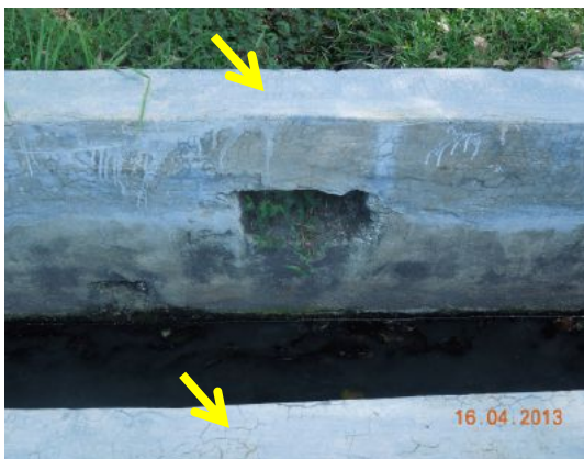
Gambar 1.42 Lepaan Dinding Longkang Tidak Kemas
