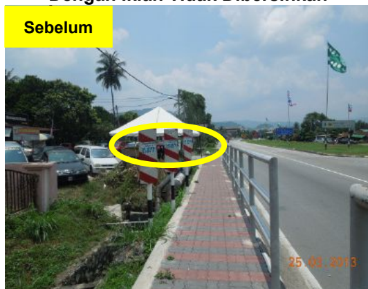
Gambar 1.9 Papan Tanda Keselamatan Yang Ditampal Dengan Iklan Tidak Dibersihkan
