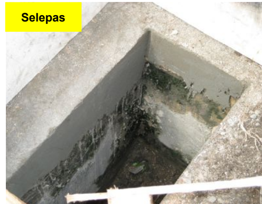
Gambar 1.33 Baik Pulih Longkang Telah Dilaksana
