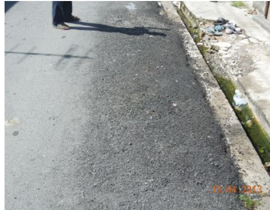
Gambar 1.39 Turapan Jalan Tidak Kemas
