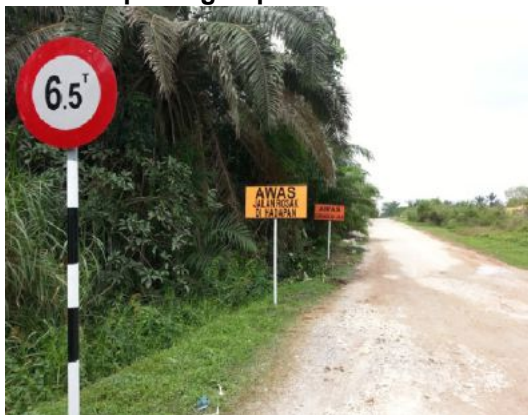
Gambar 1.14 Jalan Berlubang Telah Diletakkan Crusher Run Dan Dipasang Papan Tanda Amaran
