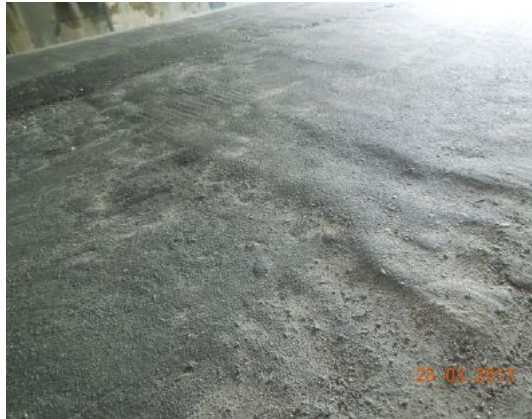
Gambar 1.7 Kecacatan Permukaan Jalan
