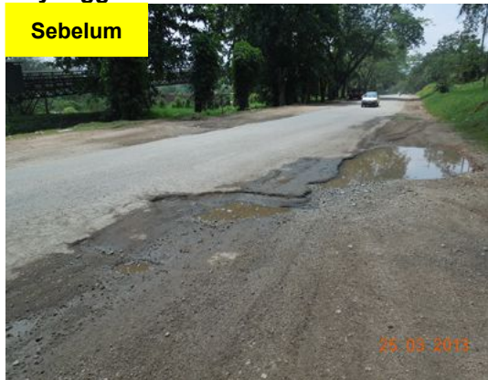
Sumber: Jabatan Audit Negara Lokasi: Jalan Bristol, Gombak Tarikh: 25 Mac 2013
