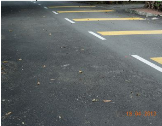
Gambar 1.38 Turapan Jalan Tidak Padat Kerana Kerja Dilakukan Semasa Hujan
