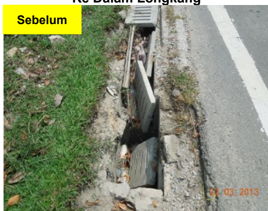
Gambar 1.57 Penutup Longkang Yang Disenggara Pada Bulan Disember 2012 Terjatuh Ke Dalam Longkang
