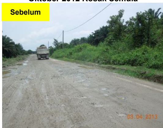
Gambar 1.43 Jalan Yang Baru Diturap Pada Bulan Oktober 2012 Rosak Semula
