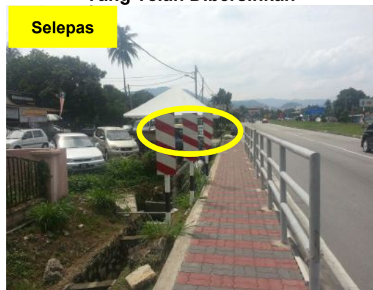
Gambar 1.10 Papan Tanda Keselamatan Yang Telah Dibersihkan
