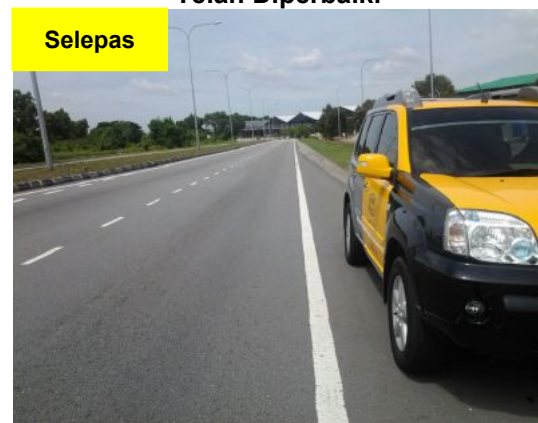
Gambar 1.29 Cat Garisan Tepi Jalan Telah Diperbaiki
