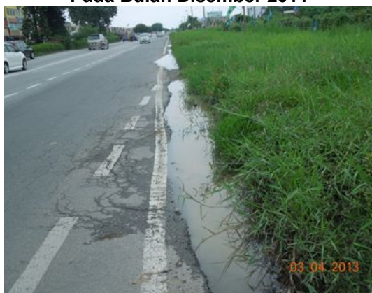
Gambar 1.45 Jalan Retak Kerana Air Bertakung Di Bahu Jalan Yang Disenggara Pada Bulan Disember 2011
