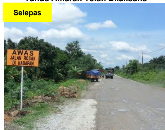
Gambar 1.44 Penurapan Jalan Dan Pemasangan Papan Tanda Amaran Telah Dilaksana
