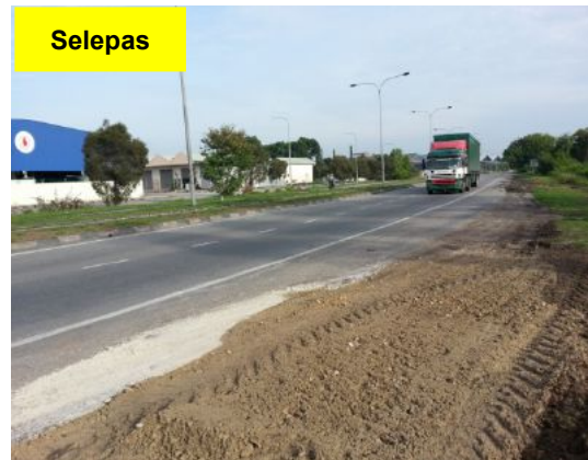
Gambar 1.22 Pembaikan Bahu Jalan Telah Dilaksana
