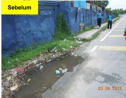
Gambar 1.47 Air Bertakung Di Bahu Jalan Yang Disenggara Pada Bulan Disember 2011
