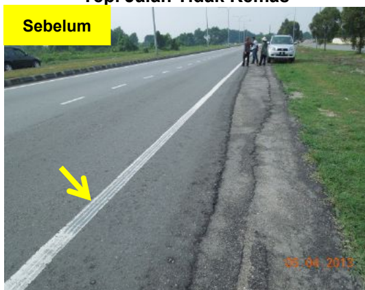
Gambar 1.28 Kecacatan Polishing Dan Cat Garisan Tepi Jalan Tidak Kemas
