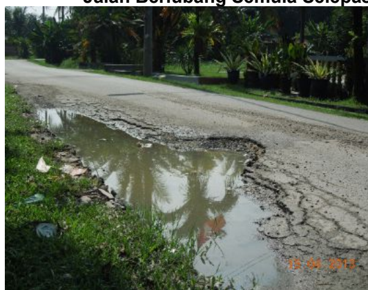
Gambar 1.61 Jalan Berlubang Semula Selepas Gambar 1.62 Disenggara Pada Bulan Disember 2012
