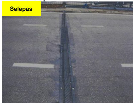
Gambar 1.35 Kerja Pembaharuan Muka Jalan Bagi Menutup Pothole Telah Dilaksana
