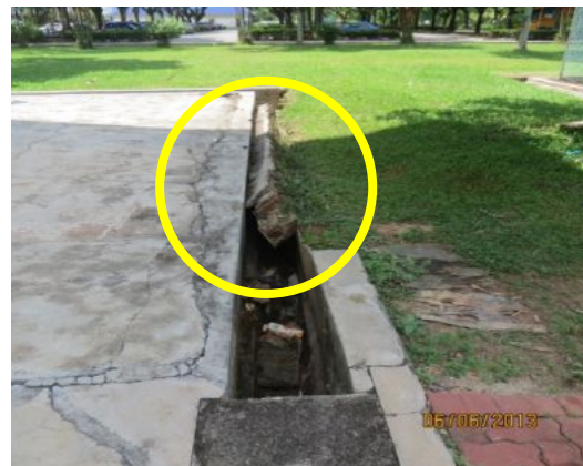
Gambar 4.5 Concrete Slab Runtuh Dan Tidak Dibaiki
