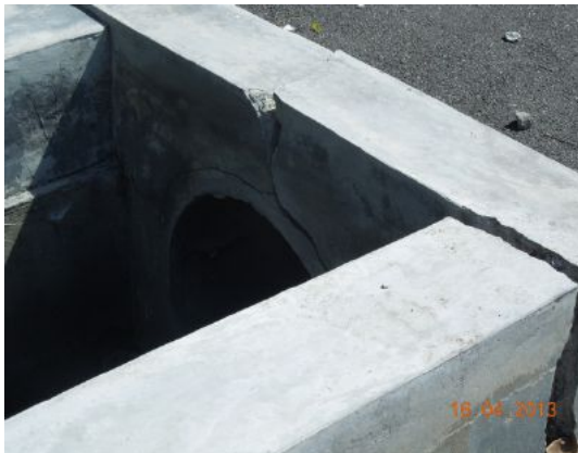
Gambar 1.40 Dinding Sump Retak
