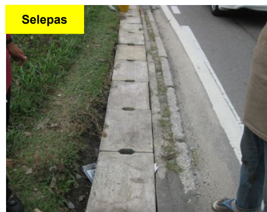
Gambar 1.58 Kerja Pembaikan Telah Dilaksana
