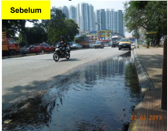
Gambar 1.25 Air Bertakung Disebabkan Lubang Salur Air Yang Tersumbat
