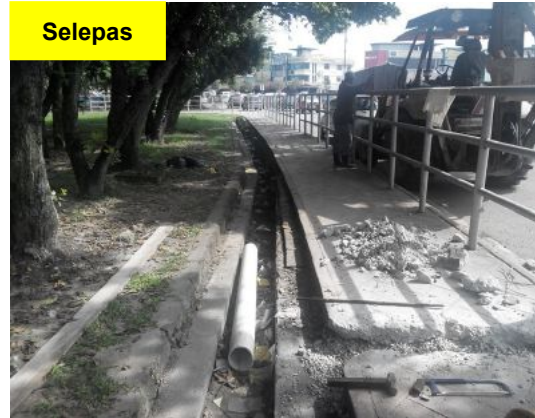
Gambar 1.26 Lubang Outlet Untuk Scupper Drain Telah Dibina
