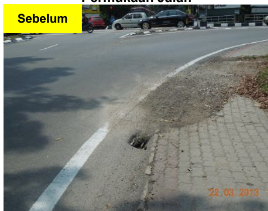
Gambar 1.59 Lubang Salur Air Berada Pada Aras Permukaan Jalan
