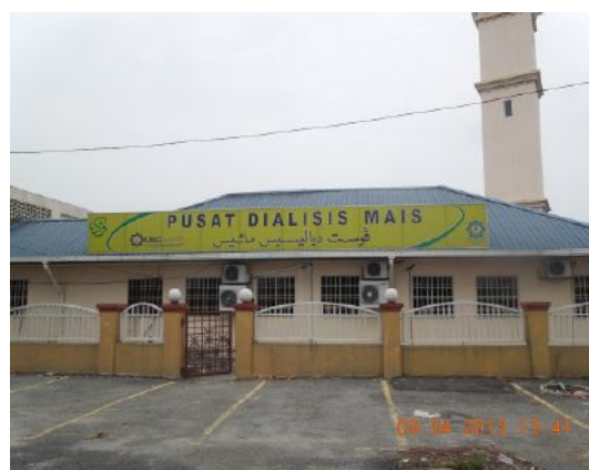
Gambar 3.2 Pusat Dialisis Di Bangunan Masjid
