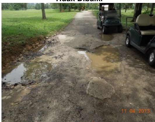
Gambar 4.1 Buggy Track Yang Berlubang Dan Tidak Dibaiki
