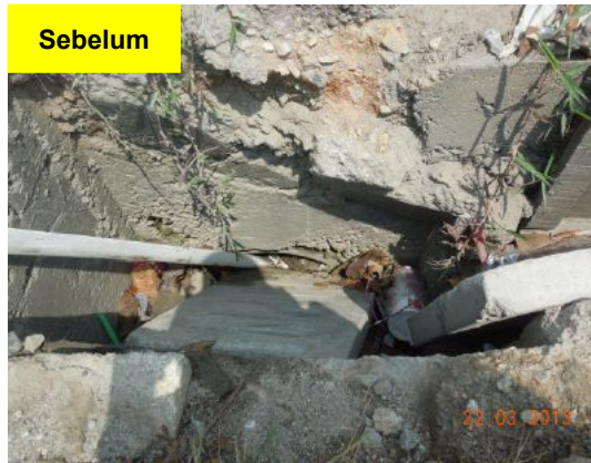
Gambar 1.32 Lepaan Dinding Dalam Longkang Konkrit Tidak Kemas
