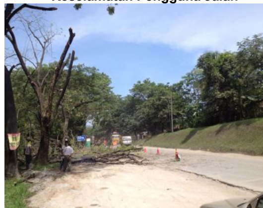
Gambar 1.17 Dahan Pokok Dicantas Atas Faktor Keselamatan Pengguna Jalan
