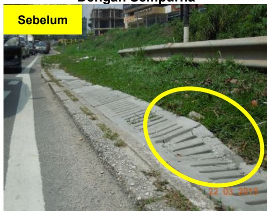
Gambar 1.36 Penutup Longkang Konkrit Tidak Dipasang Dengan Sempurna
