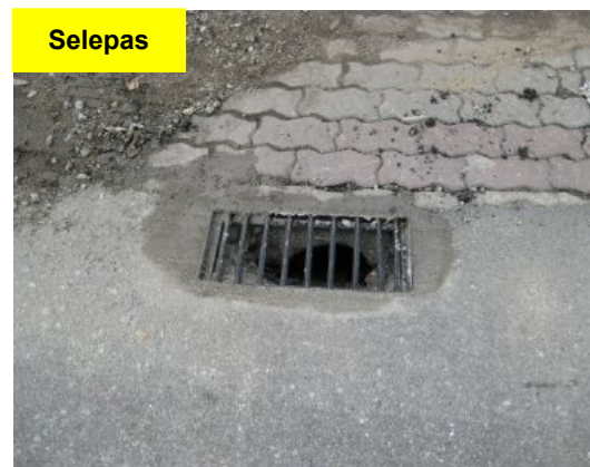
Gambar 1.60 Lubang Salur Air Ditutupi Dengan Grating
