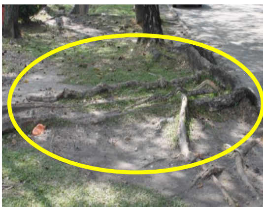
Gambar 1.13 Akar Pokok Yang Timbul Di Bahu Jalan
