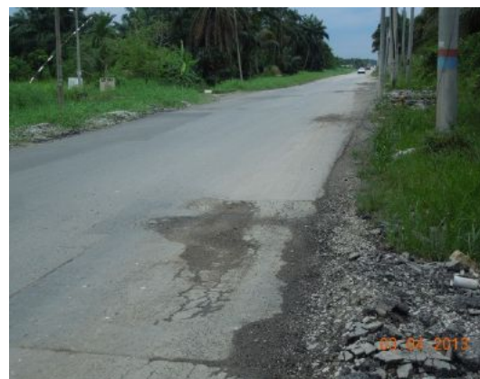
Gambar 1.46 Tampalan Pothole Pada Bulan Disember 2012 Rosak Semula
