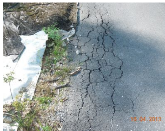
Gambar 1.64 Keretakan Di Tepi Jalan Yang Disenggara Pada Bulan Julai 2012
