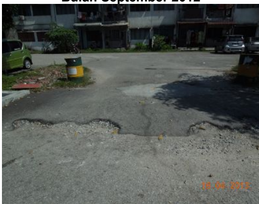
Gambar 1.63 Turapan Terkopak Selepas Kerja Pemasangan Culvert Pada Bulan September 2012
