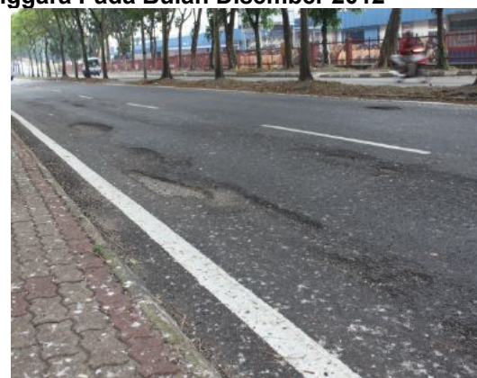
Gambar 1.61 Jalan Berlubang Semula Selepas Gambar 1.62 Disenggara Pada Bulan Disember 2012
