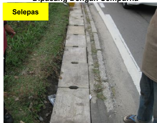
Gambar 1.37 Penutup Longkang Konkrit Telah Dipasang Dengan Sempurna
