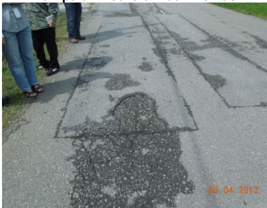
Gambar 1.30 Tampalan Pothole Tidak Kemas
