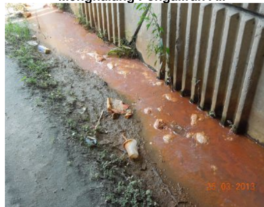
Gambar 1.24 Longkang Yang Tersumbat Dan Menghalang Pengaliran Air
