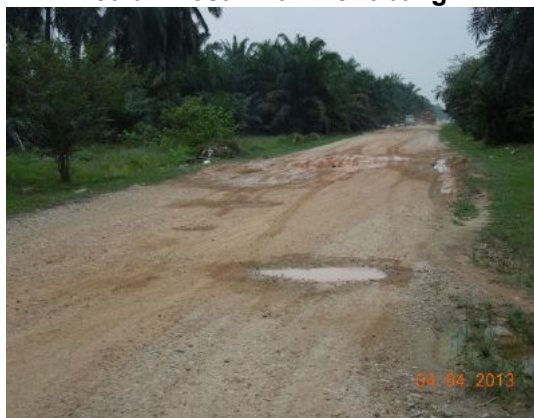
Gambar 1.3 Jalan Rosak Dan Berlubang
