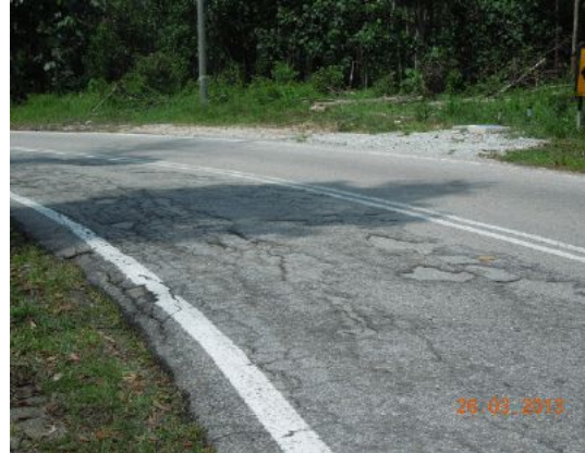
Gambar 1.6 Retakan Jalan/Jalan Rosak
