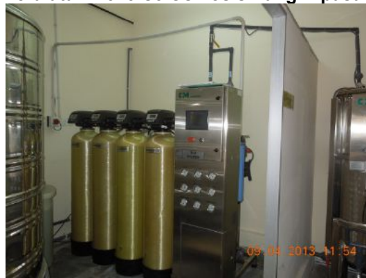
Gambar 3.6 Peralatan Reverse Osmosis Yang Dipasang
