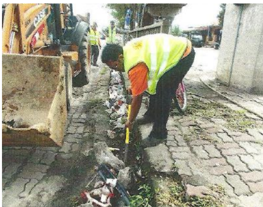
Gambar 1.16 Pembersihan Longkang Dijalankan
