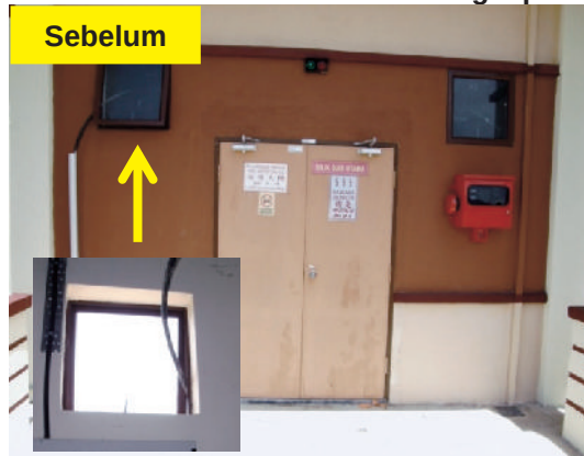
Gambar 2.21 Pendawaian Kabel Melalui Tingkap
