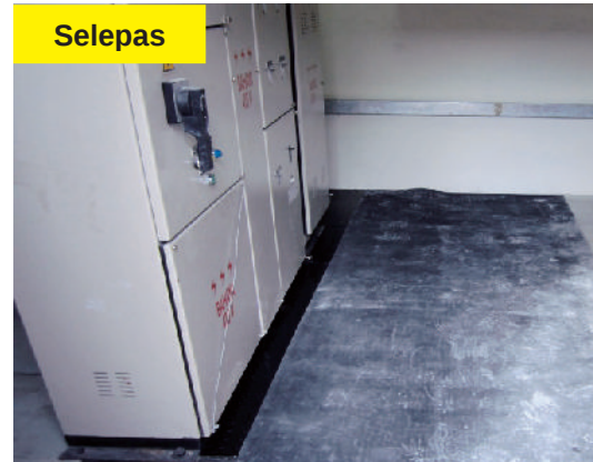
Gambar 2.12 Kedudukan MSB Telah Diubah
