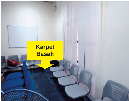
Gambar 2.5 Titisan Air Daripada Penghawa Dingin Telah Menyebabkan Karpét Basah Dan Kesan Resapan Air Pada Siling
