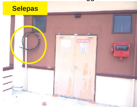
Gambar 2.22 Kabel Telah Ditanggalkan
