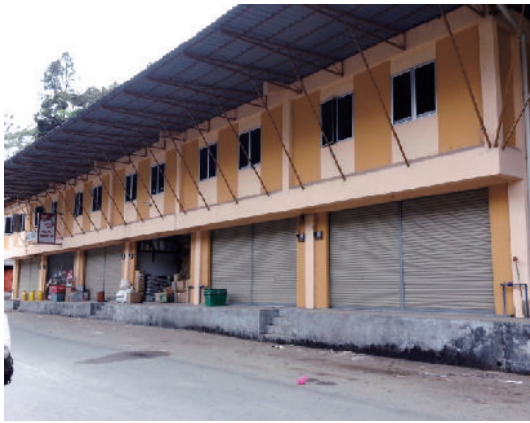
Gambar 3.1 Pembinaan Bangunan Kekal Dua Tingkat
