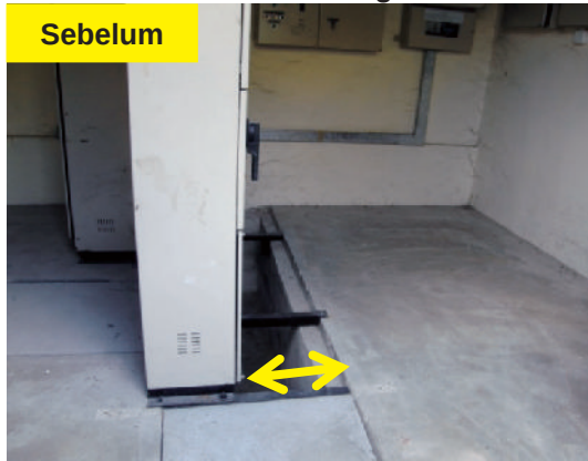
Gambar 2.11 Saiz Trenches Yang Besar
