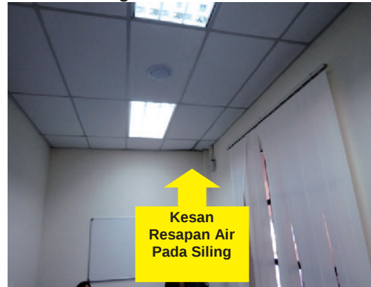
Gambar 2.5 Titisan Air Daripada Penghawa Dingin Telah Menyebabkan Karpét Basah Dan Kesan Resapan Air Pada Siling
