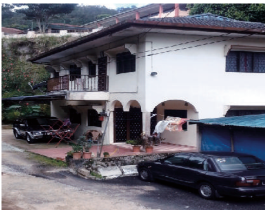
Gambar 3.2 Pembinaan Rumah Kekal 2 Tingkat
