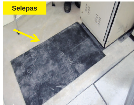
Gambar 2.10 Pelapik Getah Telah Diletakkan Di Atas Lantai
