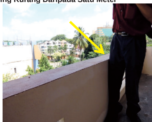
Gambar 2.1 Dinding Parapet – Ketinggian Dinding Kurang Daripada Satu Meter
