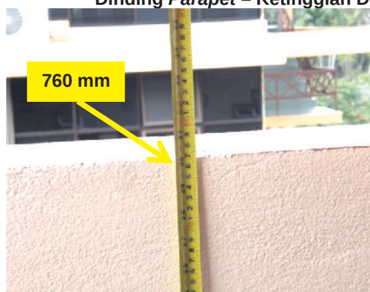
Gambar 2.1 Dinding Parapet – Ketinggian Dinding Kurang Daripada Satu Meter
