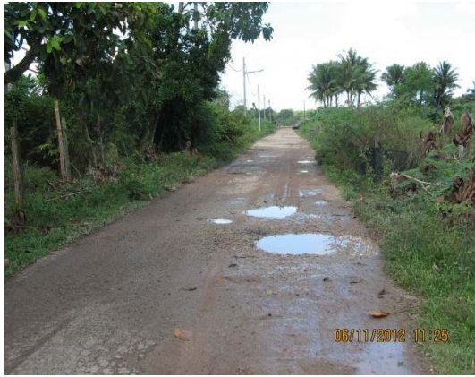
Gambar 3.33 Jalan Keluar Masuk Ke Tapak Pelupusan MDPM Tidak Berturap, Tidak Rata Dan Berlubang
