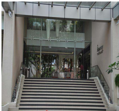
Gambar 3.5 Tiada Laluan OKU di Pintu Masuk
