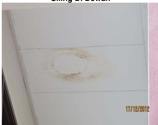
Gambar 2.11 Kesan Resapan Air Pada Permukaan Siling Di Dewan
