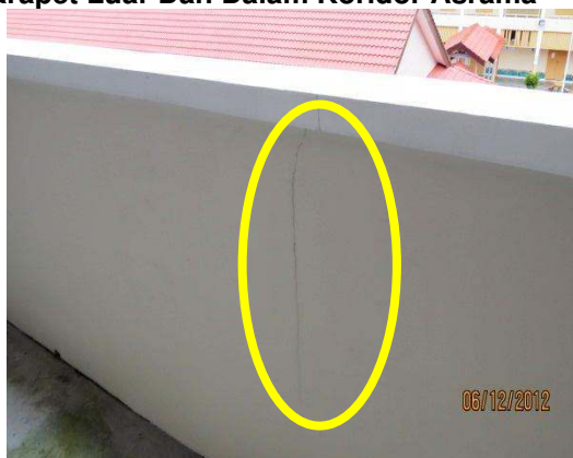
Gambar 2.6 Keretakan Pada Permukaan Dinding Parapet Luar Dan Dalam Koridor Asrama
