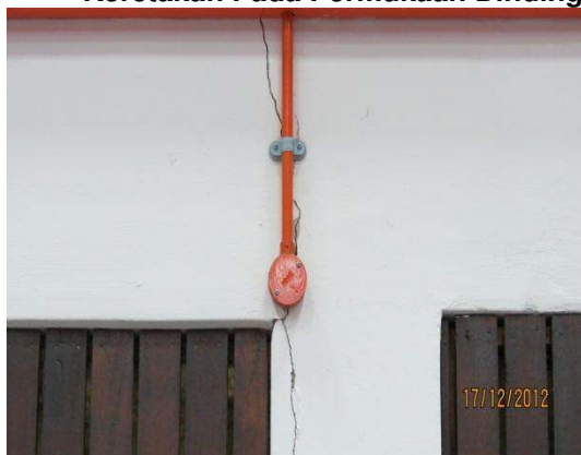
Gambar 2.10 Keretakan Pada Permukaan Dinding Bahagian Dalam Dan Belakang Dewan
