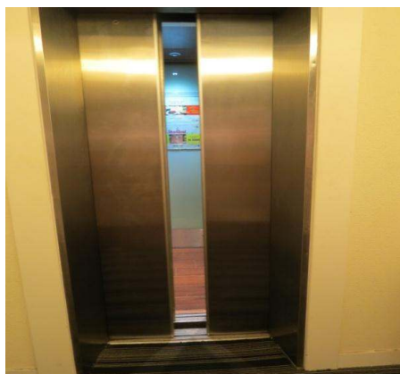
Gambar 3.7 Pintu Lif Utama Rosak
