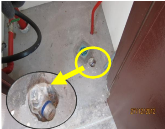
Gambar 2.13 Lubang Lantai Ditutup Dengan Botol
