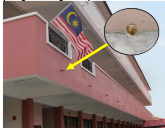
Gambar 2.2 Penutup Perangkap Tidak Dipasang Tetapi Diganti Dengan Paip Saluran Keluar
