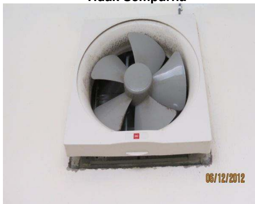
Gambar 2.8 Kerja Pemasangan Exhaust Fan Tidak Sempurna
