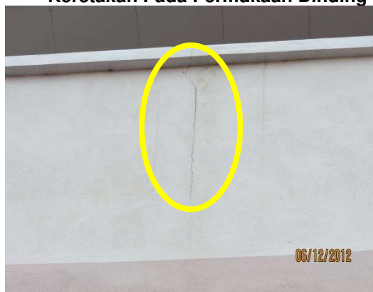
Gambar 2.6 Keretakan Pada Permukaan Dinding Parapet Luar Dan Dalam Koridor Asrama
