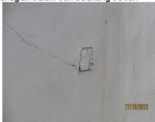
Gambar 2.10 Keretakan Pada Permukaan Dinding Bahagian Dalam Dan Belakang Dewan
