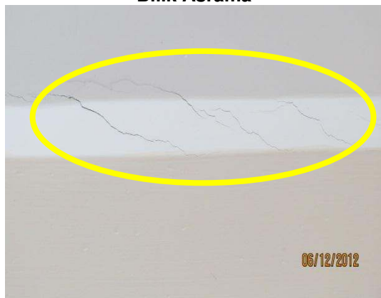
Gambar 2.7 Keretakan Pada Permukaan Dinding Bilik Asrama
