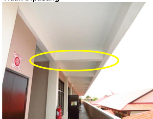
Gambar 2.4 Paip Buangan Air Tidak Dipasang
