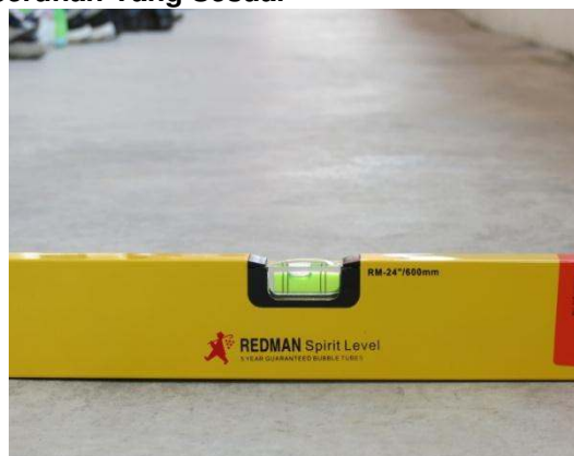
Gambar 2.1 Permukaan Koridor Asrama Tidak Mempunyai Kecerunan Yang Sesuai
