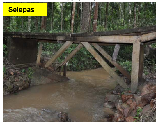
Gambar 2.16 Dahan Dan Ranting Kayu Yang Telah Dibersihkan
