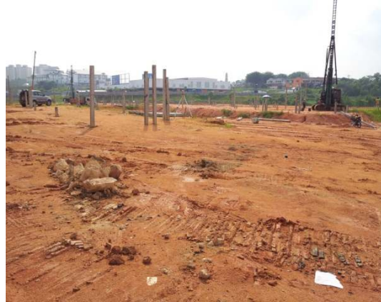
Gambar 5.2 Kerja Menanam Cerucuk Di Tapak Pembinaan
