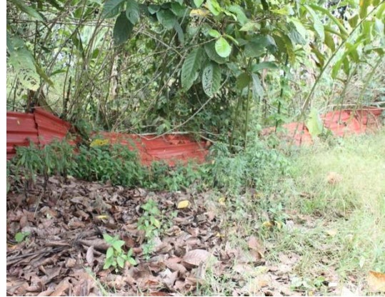
Gambar 4.12 Pagar Ladang Runtuh Belum Dibaiki
