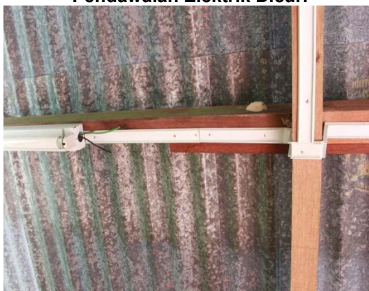
Gambar 2.29 Pendawaian Elektrik Dicuri
