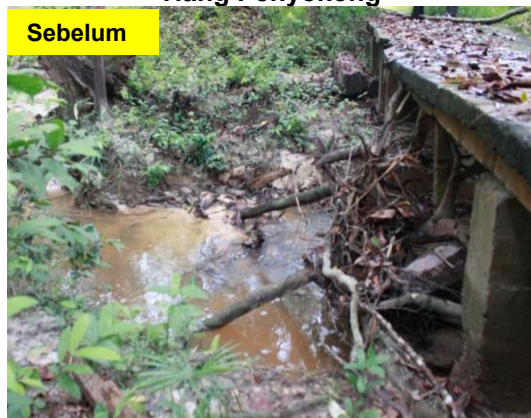
Gambar 2.15 Dahan Dan Ranting Kayu Tersangkut Pada Tiang Penyokong
