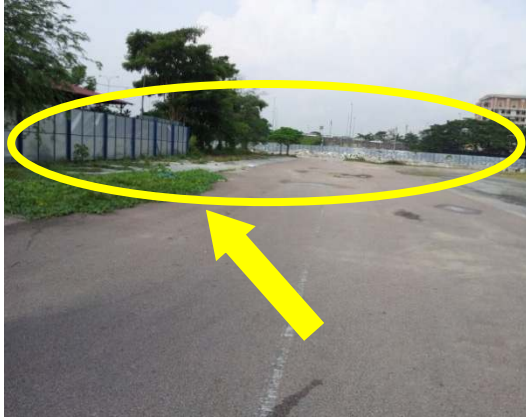
Gambar 5.1 Pemasangan Hoarding Di Kawasan Projek
