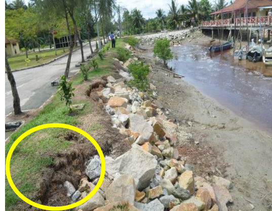
Gambar 3.4 Kesan Hakisan Tanah Di Tebing Sungai
