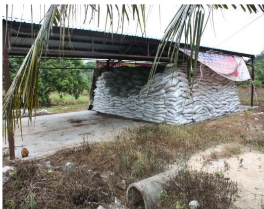
Gambar 4.13 Tempat Penyimpanan Baja Terdedah Kepada Cuaca Panas Dan Hujan
