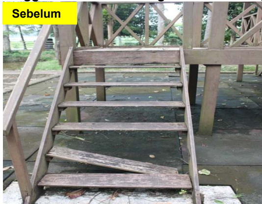
Gambar 2.11 Tangga Ke Menara Gelungsur Patah/Usang
