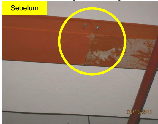
Gambar 8.1 Tidak Ada Copper Bridge Pada Sambungan Trunking
