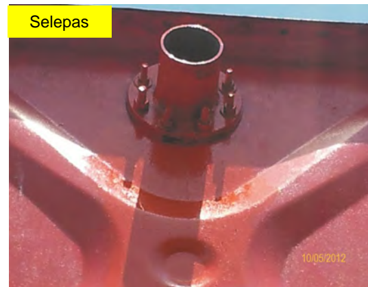
Gambar 8.4 Saluran Lebihan Air Telah Dibaiki
