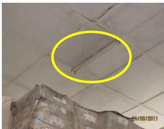
Gambar 11.4 Kesan Kebocoran Pada Siling
