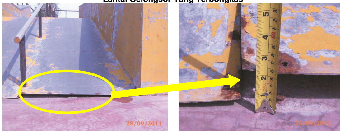
Gambar 9.6 Lantai Gelongsor Yang Terbongkas
