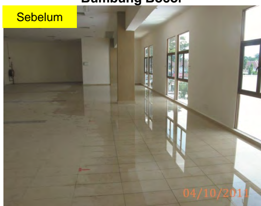
Gambar 7.11 Air Bertakung Di Lantai Disebabkan Bumbung Bocor
