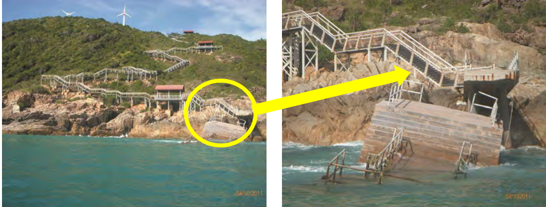
Gambar 2.1 Jeti Di Laluan Awam Ke Tapak Solar Hybrid Runtuh Belum Dibaiki
