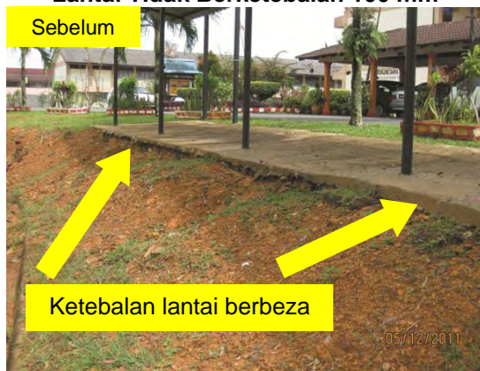
Gambar 4.5 Lantai Tidak Berketebalan 100 mm
