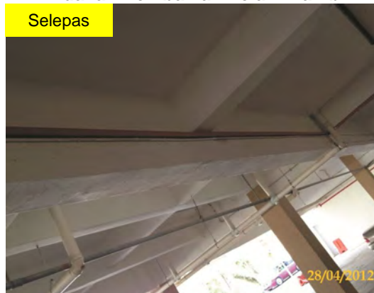
Gambar 7.8 Tindakan Pembaikan Telah Diambil
