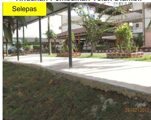
Gambar 4.6 Tindakan Pembaikan Telah Diambil
