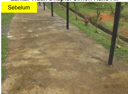
Gambar 4.7 Lantai Tidak Dilapisi Simen Kalis Air
