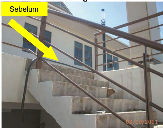
Gambar 7.17 Sambungan Kabel Elektrik Sementara Merentangi Laluan
