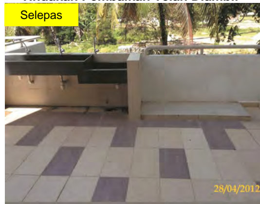
Gambar 7.4 Tindakan Pembaikan Telah Diambil
