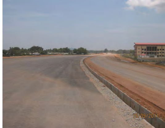
Gambar 5.2 Sebahagian Jalan Yang Siap Dibina
