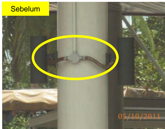
Gambar 8.7 Rantai Besi Penggantungan Lampu Berkarat
