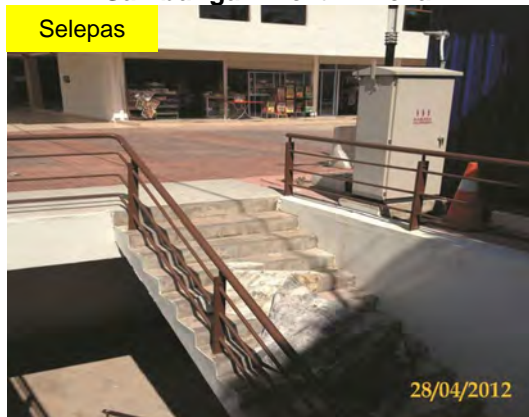
Gambar 7.18 Tiada Kabel Elektrik Sementara Selepas Sambungan Elektrik Kekal
