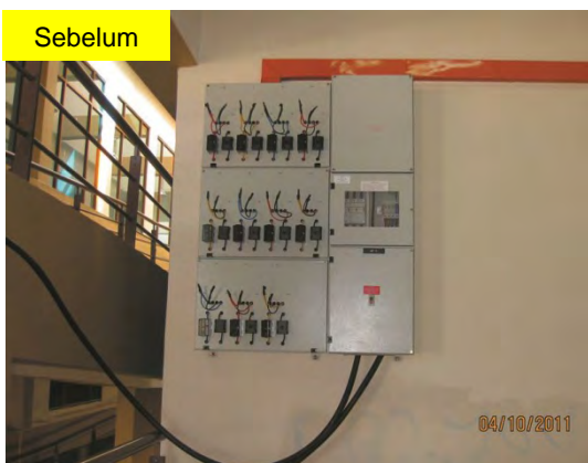
Gambar 7.19 Penyambungan Elektrik Sementara
