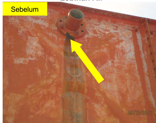
Gambar 8.3 Air Keluar ( Overflow ) Pada Saluran Lebihan Air
