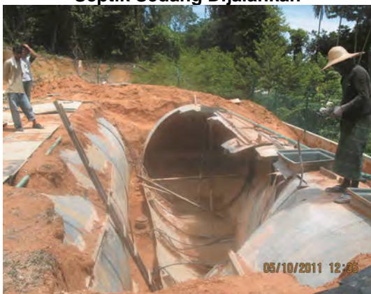
Gambar 2.2 Kerja-kerja Pembaikan Tangki Septik Sedang Dijalankan
