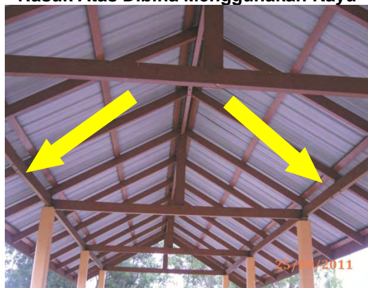
Gambar 9.1 Rasuk Atas Dibina Menggunakan Kayu
