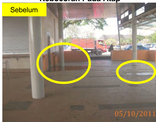
Gambar 8.13 Air Bertakung Disebabkan Kebocoran Pada Atap
