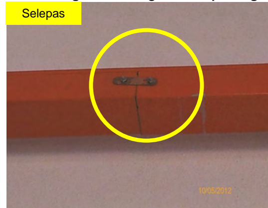
Gambar 8.2 Copper Bridge Pada Sambungan Trunking Telah Dipasang
