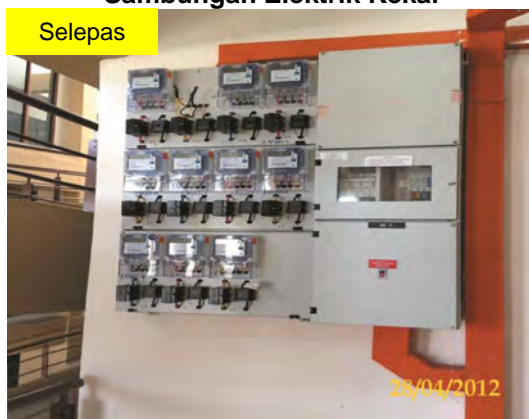
Gambar 7.20 Tiada Kabel Elektrik Sementara Selepas Sambungan Elektrik Kekal
