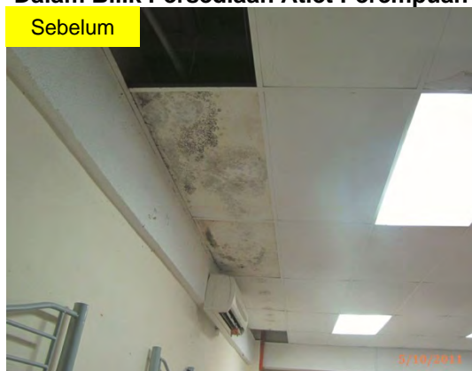
Gambar 9.9 Kesan Resapan Air Pada Siling Dalam Bilik Persediaan Atlet Perempuan
