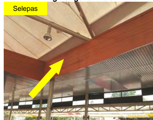
Gambar 8.10 Zink Keliling Bangunan Telah Dibaiki
