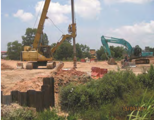
Gambar 5.1 Kerja Pembinaan Jalan Sedang Dilaksanakan
