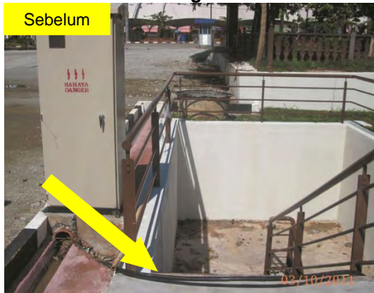
Gambar 7.15 Sambungan Kabel Elektrik Sementara Merentangi Laluan
