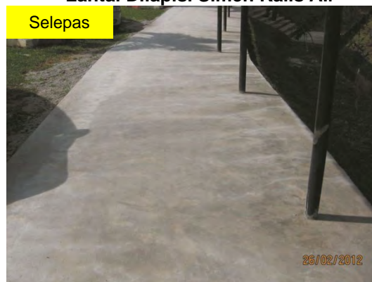
Gambar 4.8 Lantai Dilapisi Simen Kalis Air
