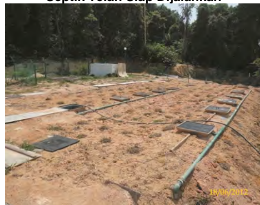
Gambar 2.3 Kerja-kerja Pembaikan Tangki Septik Telah Siap Dijalankan
