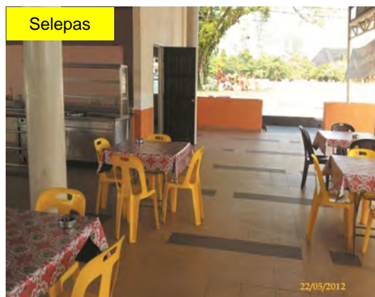
Gambar 8.14 Kebocoran Pada Atap Telah Dibaiki
