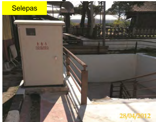
Gambar 7.16 Tiada Kabel Elektrik Sementara Selepas Sambungan Elektrik Kekal
