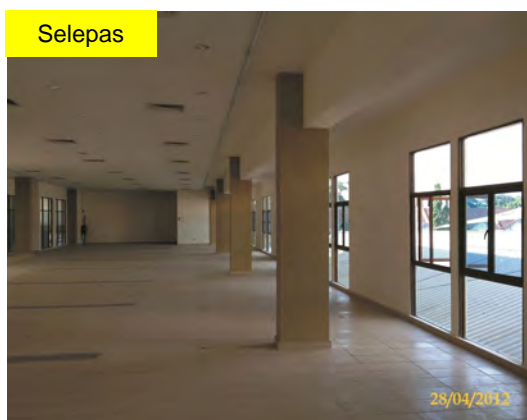
Gambar 7.12 Tindakan Pembaikan Telah Diambil
