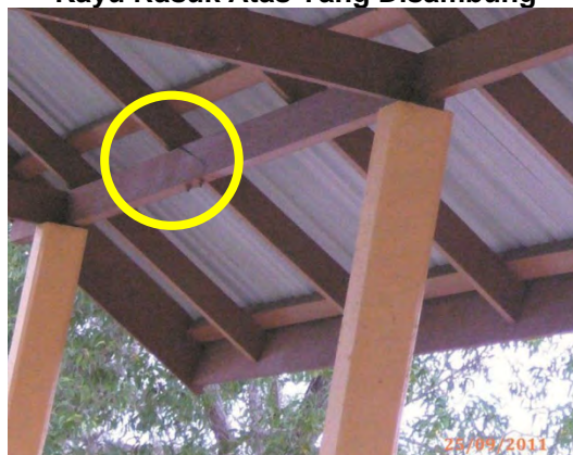
Gambar 9.2 Kayu Rasuk Atas Yang Disambung
