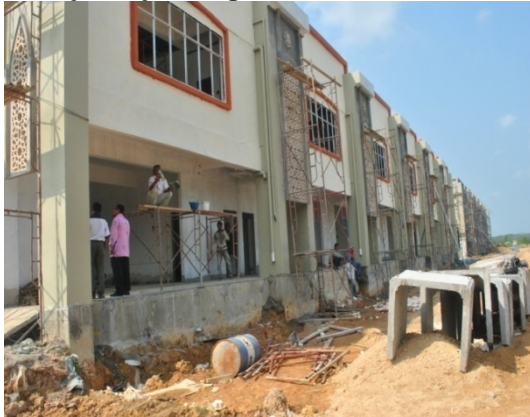
Gambar 7.1 Kerja-kerja Mengecat Luaran Blok IKS
