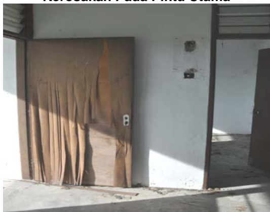
Gambar 4.8 Kerosakan Pada Pintu Utama
