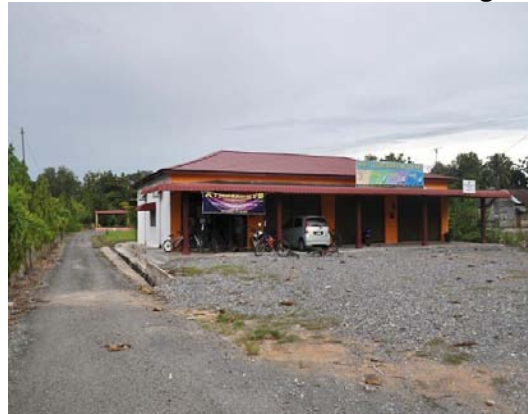
Gambar 2.4 Rumah Kedai Di Atas Tanah Berstatus Bendang
