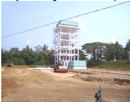
Gambar 7.3 Tangki Air 98% Siap Dan Kerja Memotong Tanah Untuk Turapan
