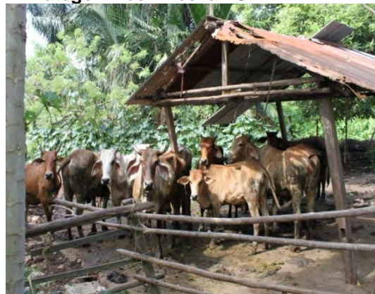
Sumber: Jabatan Audit Negara Lokasi: Kg. Bunga Tanjung 1, Kota, Rembau Tarikh: 12 Oktober 2011
