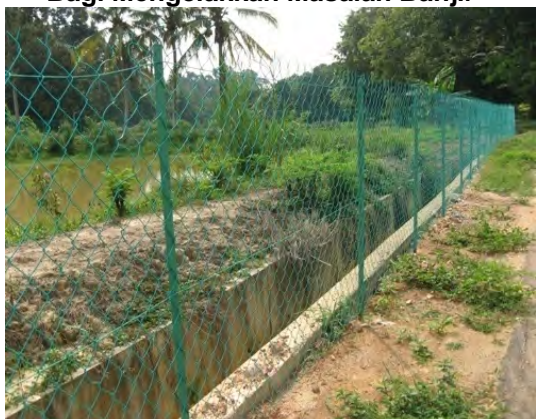
Gambar 3.5 Pembinaan Longkang Monsun "U" Drain Bagi Mengelakkan Masalah Banjir
