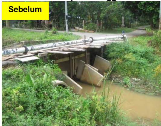
Gambar 3.1 Jambatan Lama Yang Uzur Dan Tidak Selamat Kepada Pengguna
