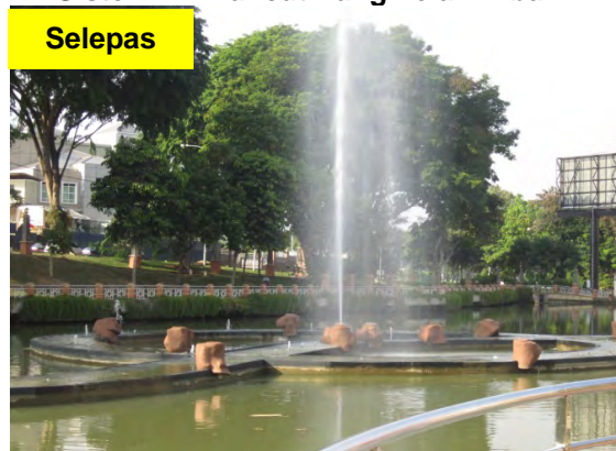
Gambar 6.7 Sistem Air Pancut Yang Telah Dibaiki
