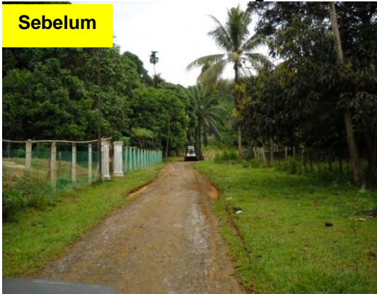
Gambar 3.3 Jalan Luar Bandar Yang Rosak
