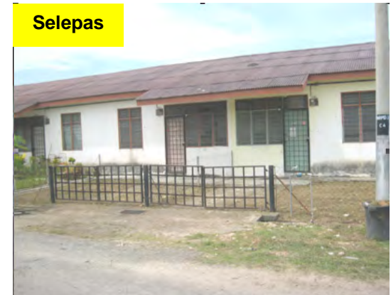
Gambar 4.6 Pintu Rumah Dan Pagar Telah Dibaiki Dan Dikunci
