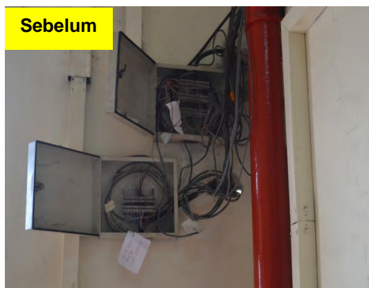
Gambar 5.5 Pendawaian Telefon Tidak Disenggarakan
