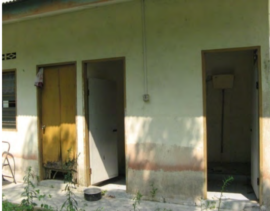
Gambar 3.11 Tandas Balai Raya Yang Rosak Kerana Tidak Disenggara
