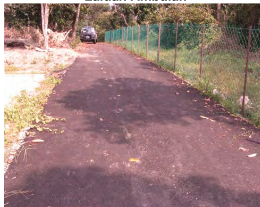
Gambar 3.6 Pembinaan Jalan Baru Bagi Kemudahan Laluan Ambulan
