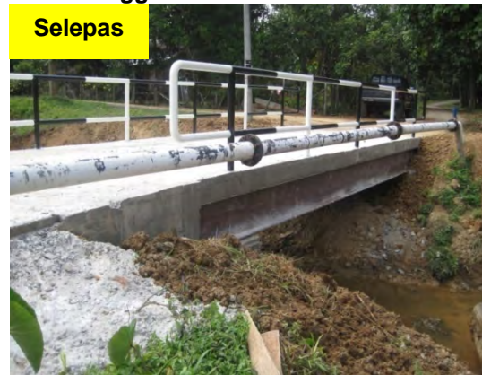
Gambar 3.2 Jambatan Baru Jenis MTB Menggantikan Jambatan Lama
