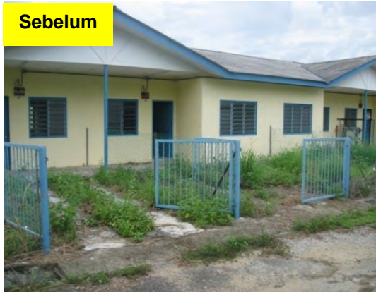
Gambar 4.1 Pintu Rumah Dan Pagar Terbuka Tidak Berkunci
