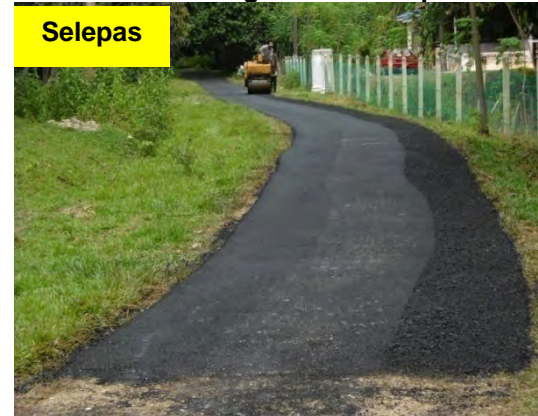
Gambar 3.4 Jalan Yang Telah Diturap
