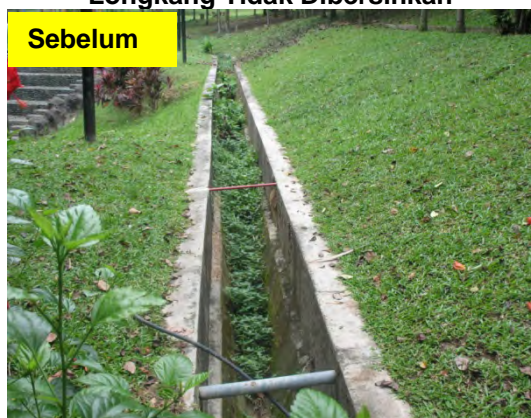
Gambar 6.15 Longkang Tidak Dibersihkan
