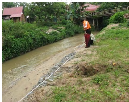
Gambar 3.8 Pengukuran Semula Projek Pembinaan Gabion
