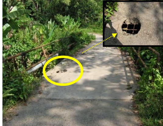
Gambar 3.12 Jambatan Yang Berlubang Dan Tidak Selamat Kepada Pengguna
