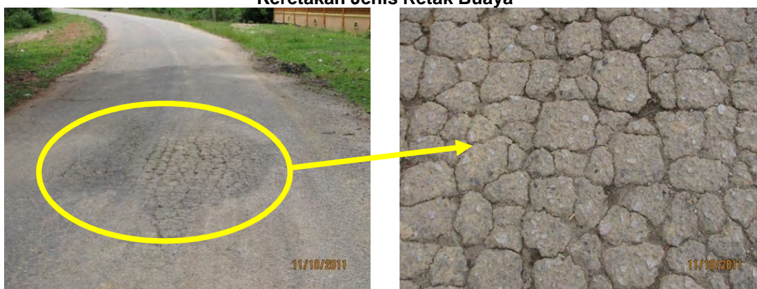
Gambar 3.7 Keretakan Jenis Retak Buaya
