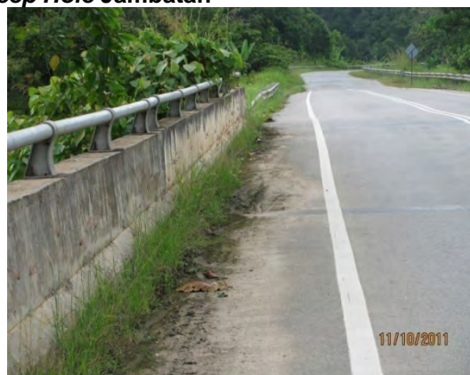
Gambar 3.37 Rumput Menutupi Weep Hole Jambatan
