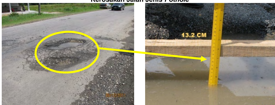
Gambar 3.14 Kerosakan Jalan Jenis Pothole
