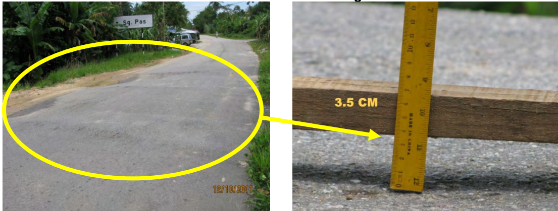
Gambar 3.8 Kerosakan Jalan Jenis Corrugation
