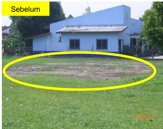
Gambar 5.21 Permukaan Gelanggang Retak Dan Pecah
