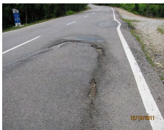
Gambar 3.6 Keretakan Permukaan Jalan Jenis Crescent Shaped Crack
