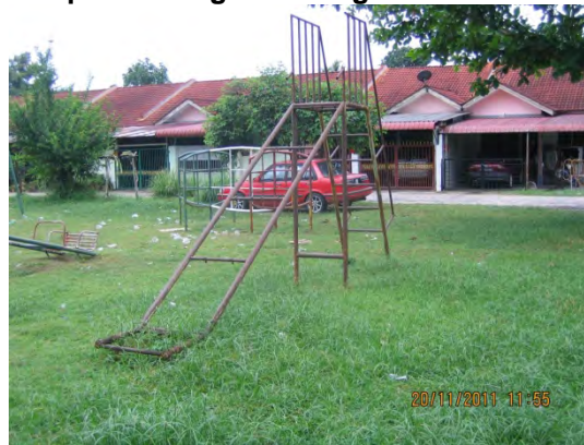
Gambar 5.7 Besi Tempat Duduk Hilang Dan Papan Gelongsor Hilang
