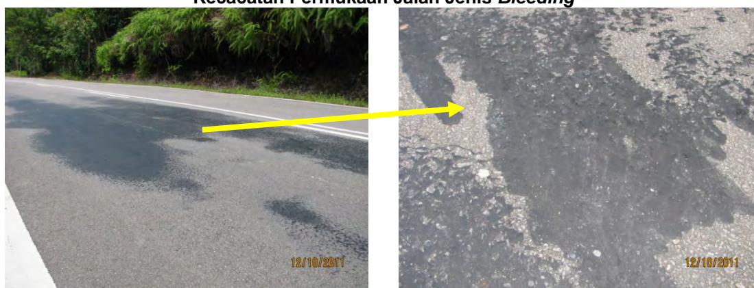
Gambar 3.5 Kecacatan Permukaan Jalan Jenis Bleeding
