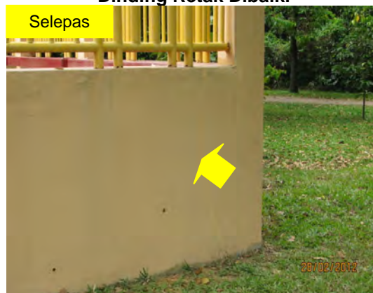
Gambar 5.30 Dinding Retak Dibaiki
