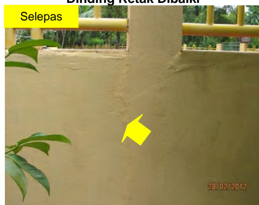
Gambar 5.32 Dinding Retak Dibaiki
