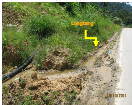
Gambar 3.40 Penyenggaraan Longkang Tidak Dibuat
