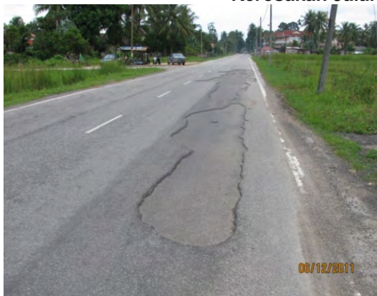
Kerosakan Jalan Jenis Delamination
