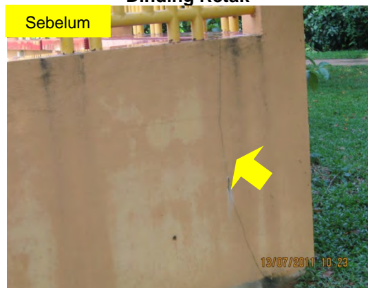
Gambar 5.29 Dinding Retak
