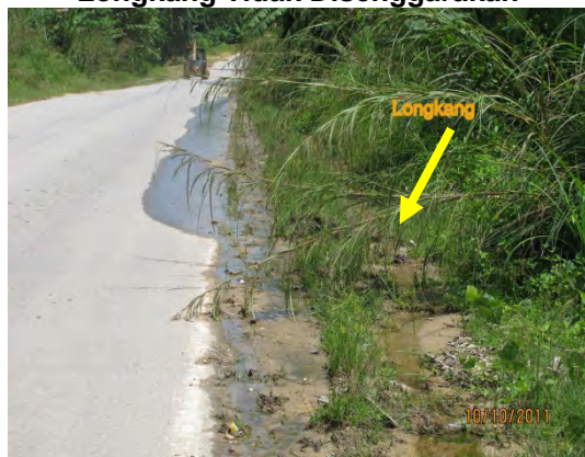
Gambar 3.39 Air Mengalir Ke Jalan Raya Disebabkan Longkang Tidak Disenggarakan
