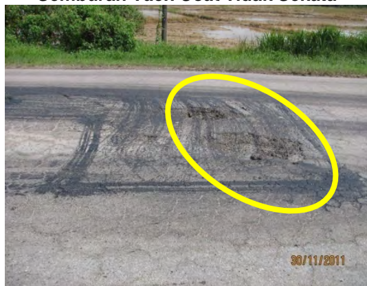
Gambar 3.17 Semburan Tack Coat Tidak Sekata
