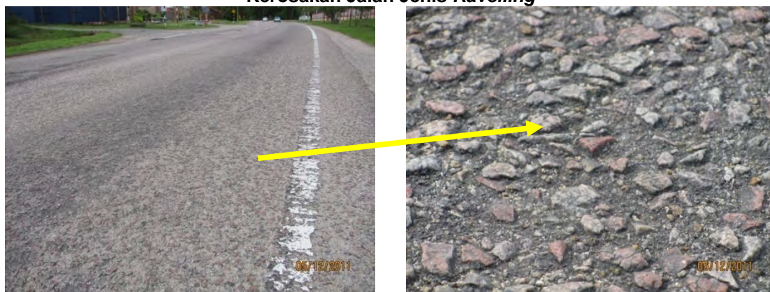
Kerosakan Jalan Jenis Ravelling
