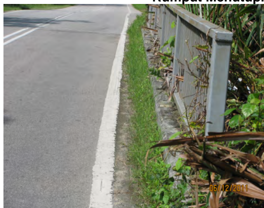
Gambar 3.37 Rumput Menutupi Weep Hole Jambatan
