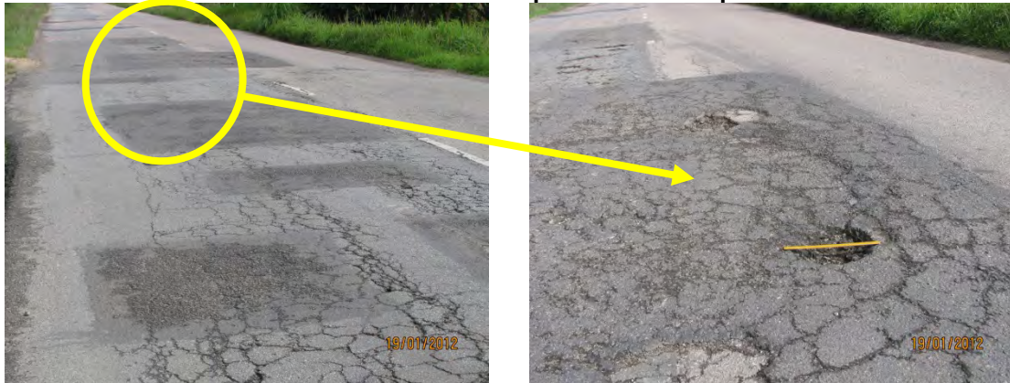
Gambar 3.21 Kesan Retakan Dan Pothole Selepas 50 Hari Tampalan Dibuat
