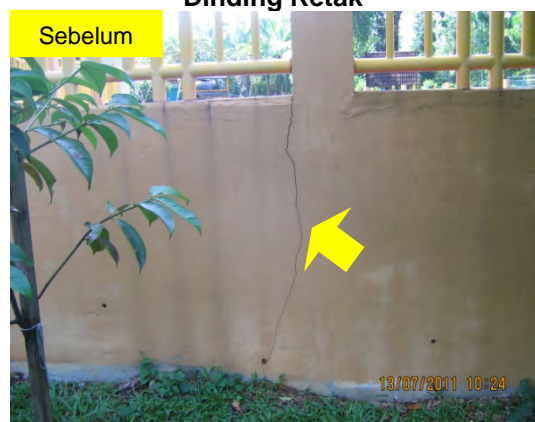
Gambar 5.31 Dinding Retak
