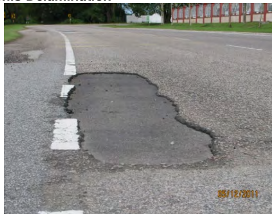
Kerosakan Jalan Jenis Delamination
