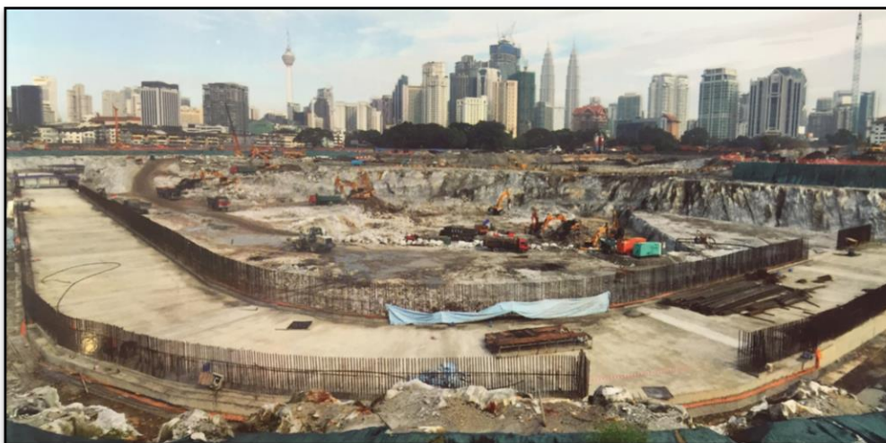
GAMBAR 4.2 KERJA PEMBANGUNAN INFRASTRUKTUR PROJEK TRX PADA BULAN NOVEMBER 2015
