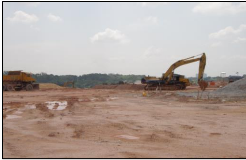
GAMBAR 4.3 KERJA PEMBINAAN LANDASAN DI RMP SUBANG
