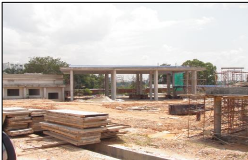
GAMBAR 4.5 DEWAN DALAM PEMBINAAN DI RMP SUBANG
