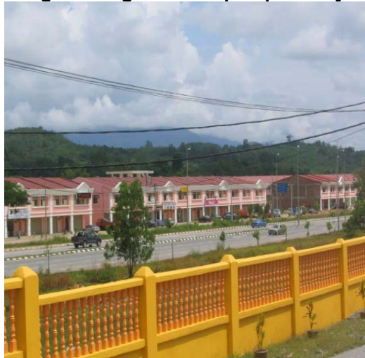
Foto 33 Pembinaan Rumah Kedai/Pejabat 2 Tingkat Yang telah Siap Sepenuhnya
