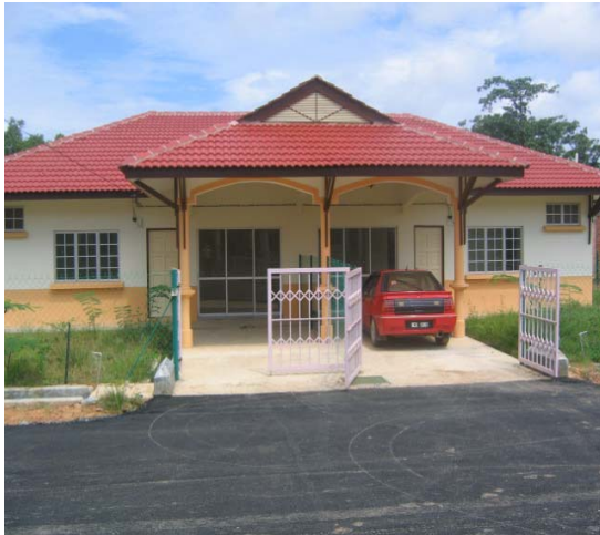
Sumber : Fail Foto Jabatan Audit Tarikh : 3 Mei 2006 Lokasi : Fasa II Taman Mesra Gua Musang
