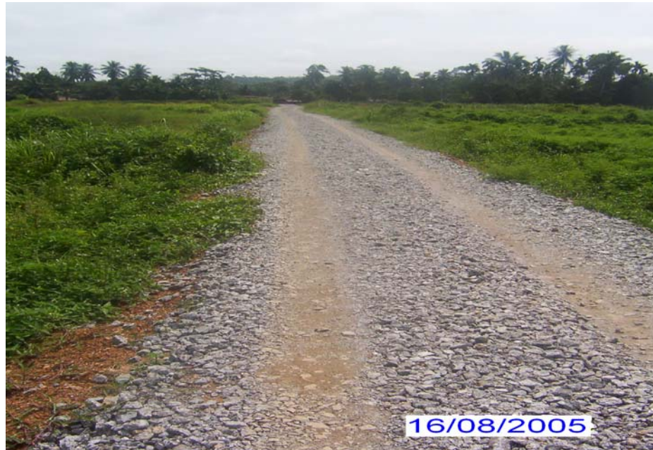
Foto 3 Membatu Jalan Ladang
