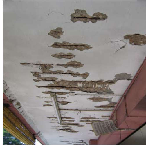
Foto 24 Rekahan Bangunan Yang Begitu Ketara
