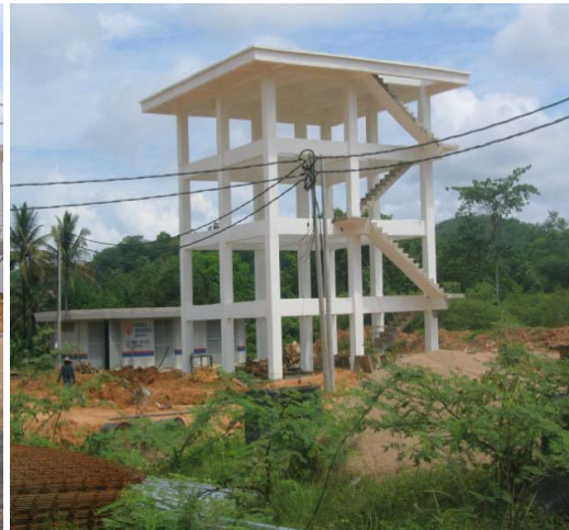
Sumber : Fail Foto Jabatan Audit Tarikh : 3 Mei 2006 Lokasi : Fasa II Taman Mesra Gua Musang
