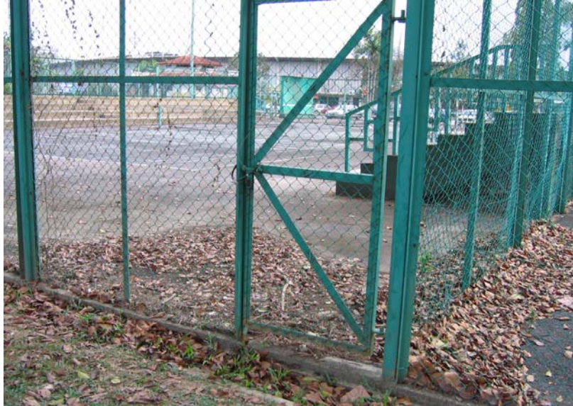
Foto 26 Keadaan Gelanggang Tenis Yang Tidak Disenggara
