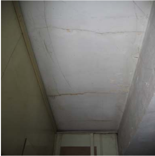
Foto 23 Retakan Pada Bangunan Stadium
