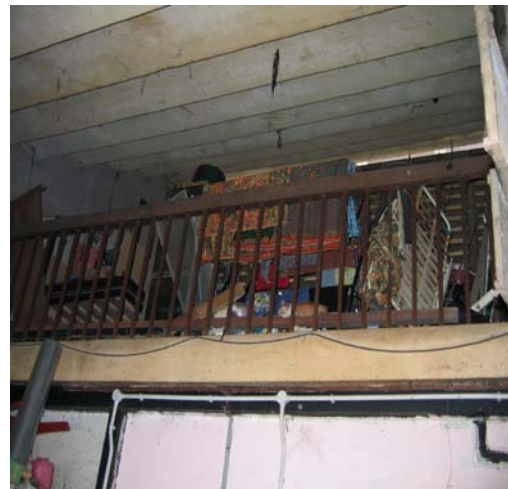
Foto 15 Pengubahsuaian Ruang Premis Di Tingkat Atas Untuk Dijadikan Tempat Tinggal
