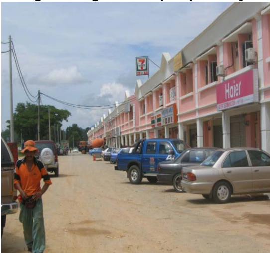
Foto 32 Pembinaan Rumah Kedai/Pejabat 2 Tingkat Yang telah Siap Sepenuhnya
