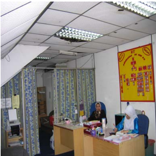
Foto 14 Pengubahsuaian Ruang Premis Di Tingkat Atas Dijadikan Pejabat
