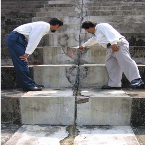
Foto 19 Rekahan Pada Expansion Gap
