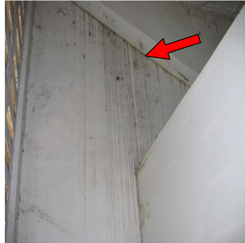
Foto 20 Kesan Kebocoran Air Hujan Dalam Gudang Penyewa
