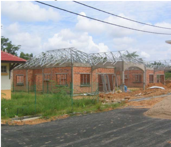
Sumber : Fail Foto Jabatan Audit Tarikh : 3 Mei 2006 Lokasi : Fasa II Taman Mesra Gua Musang
