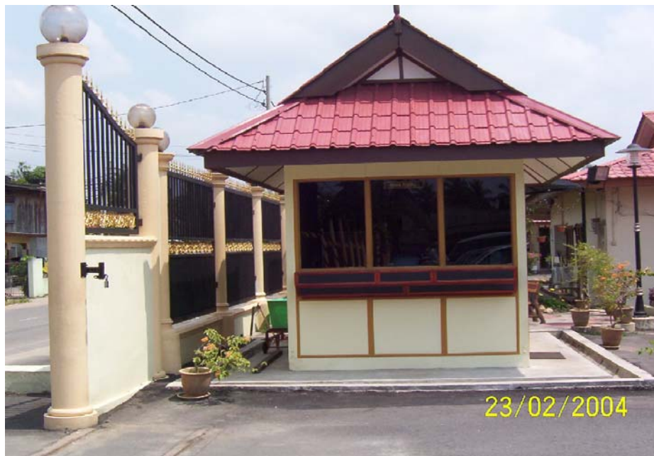
Sumber :Fail Foto Jabatan Audit Lokasi : Pejabat JKR Jajahan Pasir Mas
