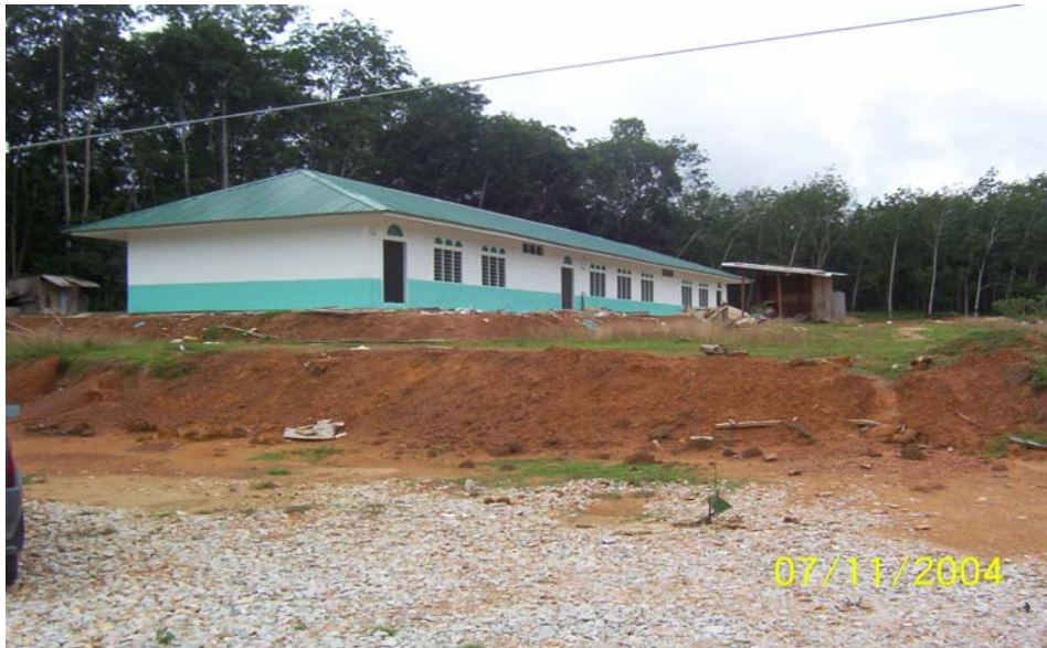
Sumber : Gambar Foto Jabatan Audit Lokasi : Bangunan Asrama SMU(A) Diniyah Pangkal Jenerih, Machang
