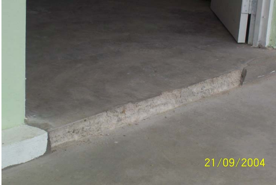
Foto 10 Lepaan Di Permukaan Pintu Masuk Tidak Dibuat
