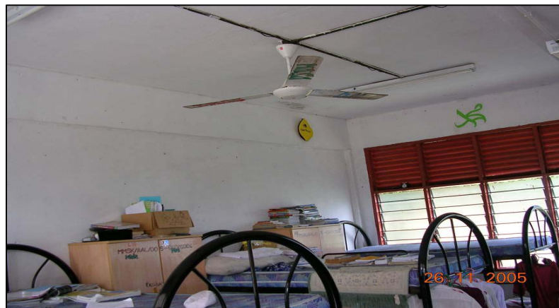
Foto 15 Kipas Siling Dipasang Terlalu Rendah
