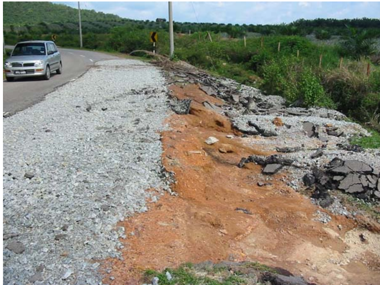
Foto 2 Keadaan Mendapan Tanah Akibat Banjir Di Jalan Sg.Division/Kuala Muda Estate
