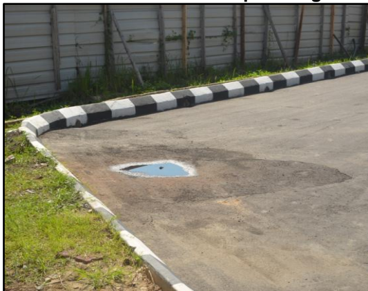
GAMBAR 3.41 Air Bertakung Di Atas Jalan Dan Memenuhi Keseluruhan Penutup Lurang
