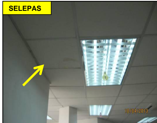
GAMBAR 8.21 Bukaan Pada Siling Gantung Disebabkan Kebocoran Paip Di Atas Siling Telah Dibaiki
