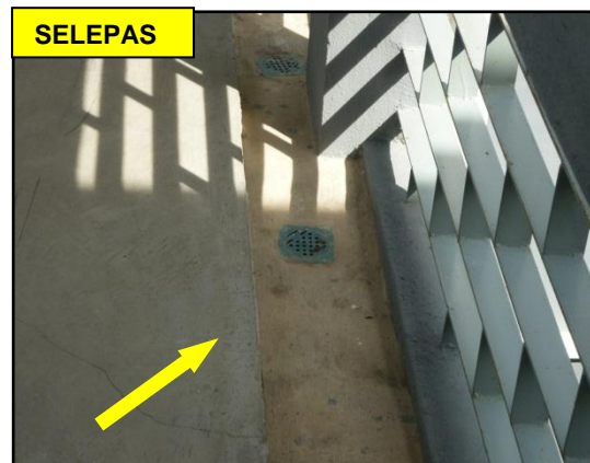
GAMBAR 6.12 Pembinaan Scupper Drain Yang Mempunyai Aras Kedalaman
