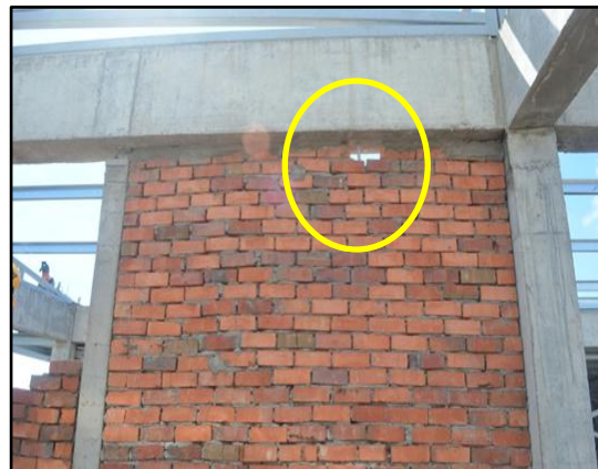
GAMBAR 3.22 Sisa Batu Bata Digunakan Bagi Pembinaan Dinding
