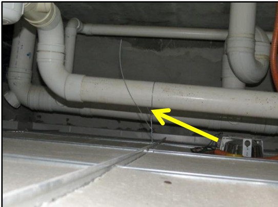
GAMBAR 8.40 Kerangka Siling Diikat Pada Saluran Paip
