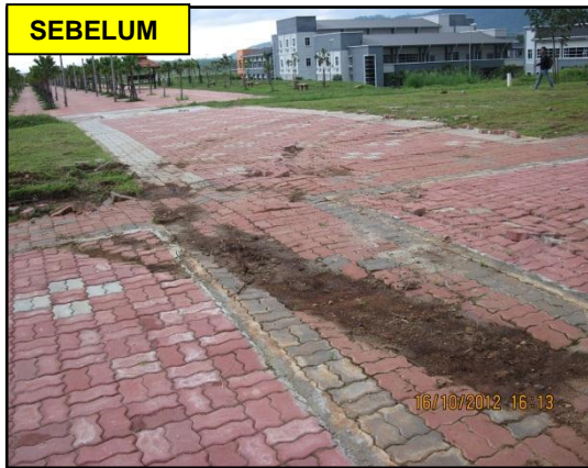
GAMBAR 6.3 Laluan Interlocking Paver Rosak
