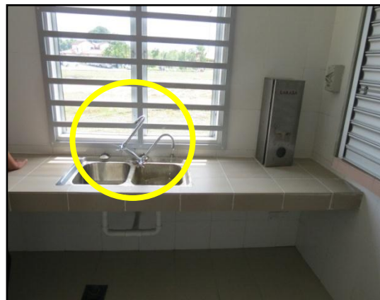
Lokasi: Aras Bawah, Kafeteria Blok Pentadbiran Tarikh: 18 Oktober 2012
