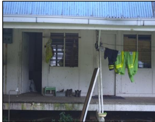
GAMBAR 5.6 Bangunan Pejabat Yang Dijadikan Penginapan Pekerja
