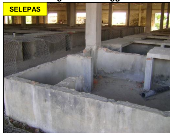
GAMBAR 3.32 Meja Gerai Yang Dirobohkan Untuk Membina Semula Meja Gerai Yang Sama Ketinggian
