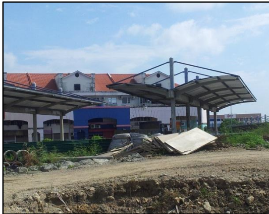
Lokasi : Tapak Projek Pembinaan Stesen Bas Dan Teksi Tarikh : 28 September 2012
