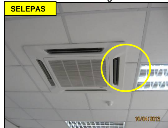
GAMBAR 8.23 Bukaan Pada Binaan Siling Telah Dibaiki
