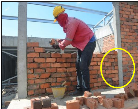
GAMBAR 3.21 Sisa Batu Bata Digunakan Bagi Pembinaan Dinding
