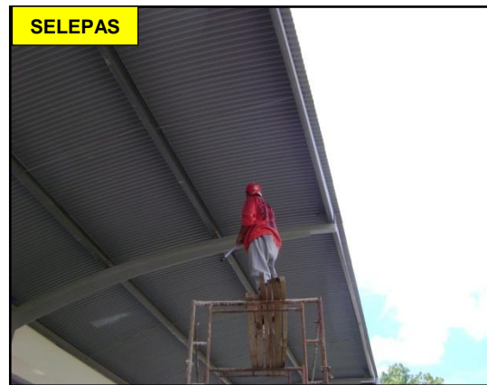
GAMBAR 3.48 Kerja Pembaikan Sedang Dilaksanakan
