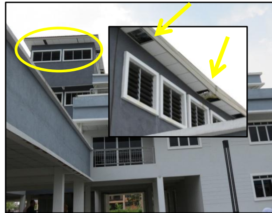
GAMBAR 8.6 Terdapat Bukaan Pada Siling Gantung
