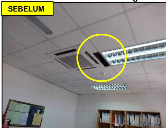
GAMBAR 8.22 Bukaan Pada Binaan Siling
