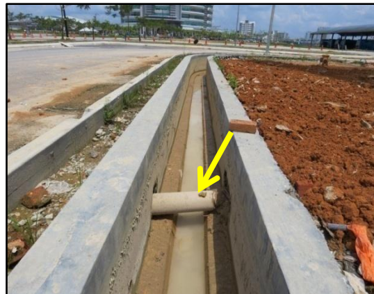
GAMBAR 8.46 Pembinaan Saluran Paip Yang Merentangi Longkang
