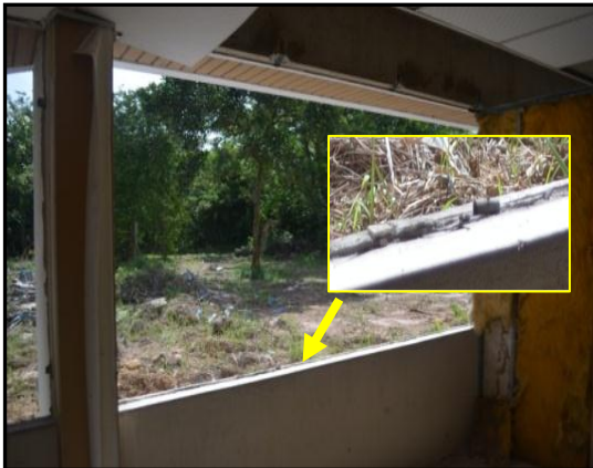
GAMBAR 5.23 Tingkap Yang Dirosakkan Untuk Mencuri Bingkai Besi
