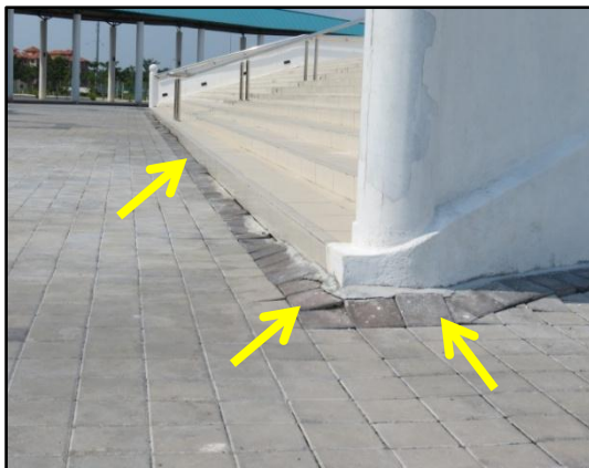
GAMBAR 8.7 Kesan Pemandapan Menyebabkan Interlocking Paver Beralun
