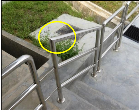
GAMBAR 8.38 Kemasan Di Bahagian Hujung Susur Tangga Tajam Dan Boleh Mendatangkan Bahaya
