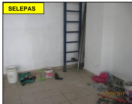
GAMBAR 8.19 Kesan Resapan Air Dan Pertumbuhan Kulat Pada Permukaan Dinding Telah Dibaiki
