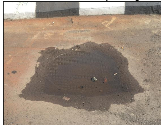
GAMBAR 3.42 Air Bertakung Di Atas Jalan Dan Memenuhi Keseluruhan Penutup Lurang
