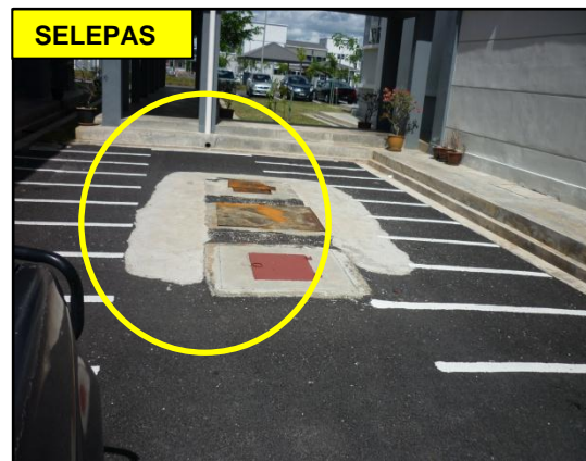
GAMBAR 6.10 Pembinaan Manhole Di Kawasan Parkir Motosikal
