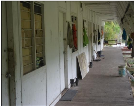
GAMBAR 5.5 Bangunan Pejabat Yang Dijadikan Penginapan Pekerja
