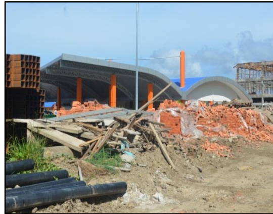
GAMBAR 3.26 Housekeeping Tapak Bina Yang Tidak Kemas
