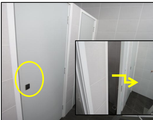
GAMBAR 8.42 Tiada Tombol Disediakan Pada Pintu Tandas Jenis Tarik Ke Luar
