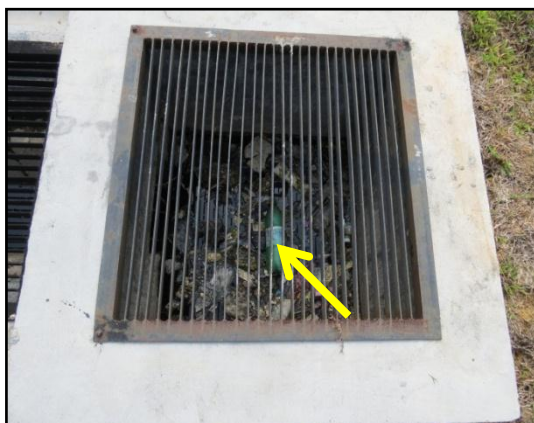
GAMBAR 8.12 Air Bertakung Dan Sampah-Sarap Tersekat Di Dalam Lurang
