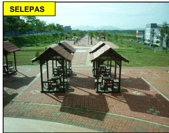
GAMBAR 6.4 Laluan Interlocking Paver Yang Telah Dibaiki
