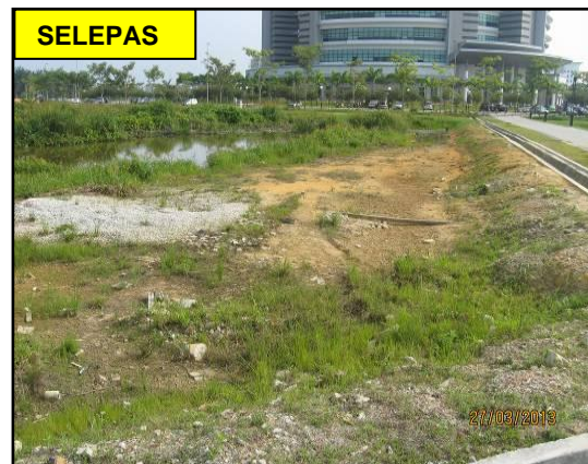
GAMBAR 8.11 Sisa Bahan Binaan Telah Dibawa Keluar
