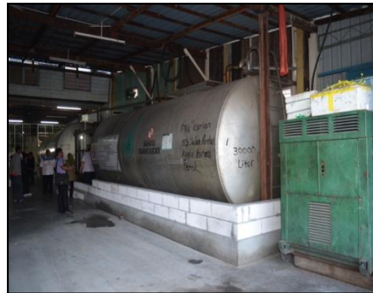
GAMBAR 2.14 Skid Tank Dalam Premis Kediaman
