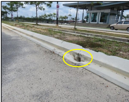
GAMBAR 8.45 Aras Outlet Untuk Bebendul Tidak Mengikut Amalan Kejuruteraan Yang Baik Dan Lebih Tinggi Daripada Aras Jalan
