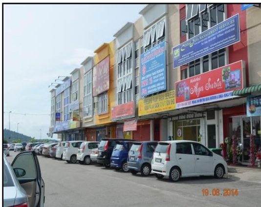
GAMBAR 15.1 Projek Fasa 1 Yang Telah Diduduki
