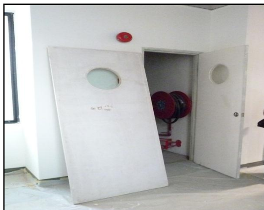
Lokasi : Bangunan Blok C, Fakulti Kejuruteraan Tarikh : 27 November 2014
