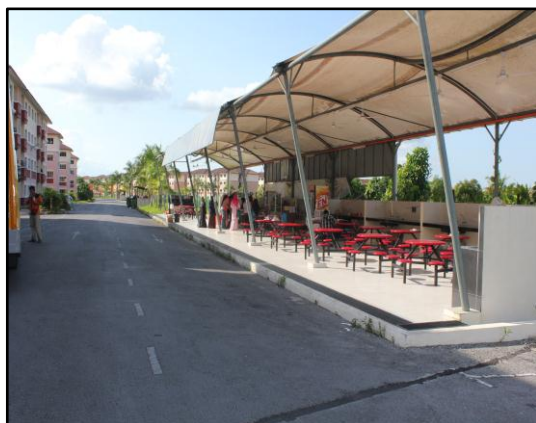
Peralatan Telah Di Edar Untuk Kegunaan Kafeteria
