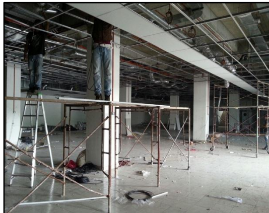
GAMBAR 5.9 Kerja Pemasangan Siling Gantung/Lampu Kalimantang/Penghawa Dingin Sedang Dilaksanakan Oleh Kontraktor Penyiap
