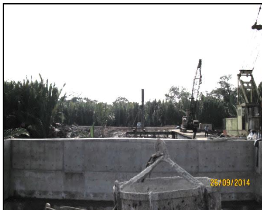
GAMBAR 8.2 Jambatan Dalam Proses Pembinaan
