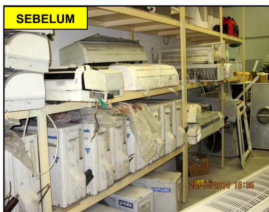
GAMBAR 4.10 Penyaman Udara Tidak Digunakan
