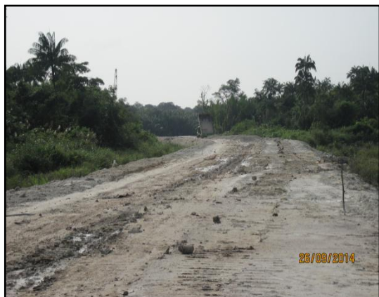
GAMBAR 8.1 Pembinaan Jalan Raya Dalam Proses Pelaksanaan
