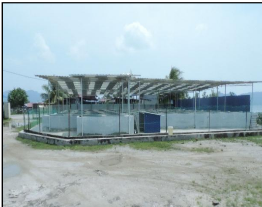
GAMBAR 2.24 Tangki Asuhan Yang Tidak Digunakan
