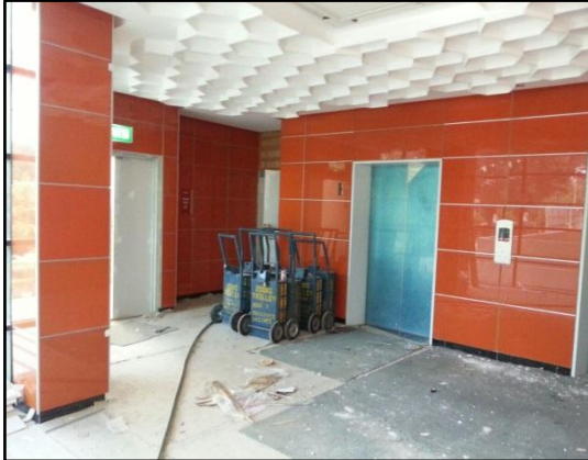
GAMBAR 5.6 Pemasangan Honeycomb Di Siling Ruang Legar Telah Siap Dan Sistem Lif Kini Menunggu Kelulusan Permit Mesin Angkut
