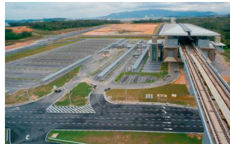
Stesen MRT - Kwasa Sentral - Tempat Letak Kenderaan untuk 500 Kereta dan 100 Motosikal (01.11.2020) (Sumber: MRT Corp)
