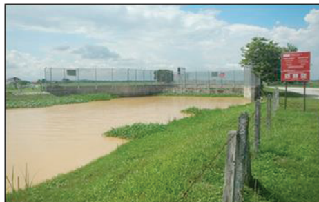
Pulau Pinang - Terusan dari Lahar Tiang ke Sungai Dua Bernilai RM51.31 Juta (05.11.2020) (Sumber: PAAB)
