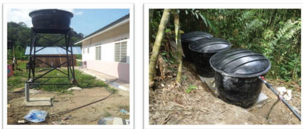
Projek Bekalan Air Terawat yang dilaksanakan di perkampungan Orang Asli
