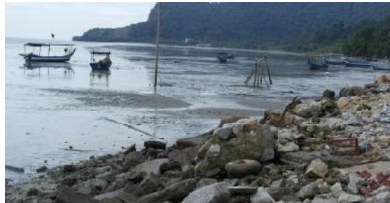
F5.9 Rip rap protection at Kampung Teluk Tempoyak Kecil
