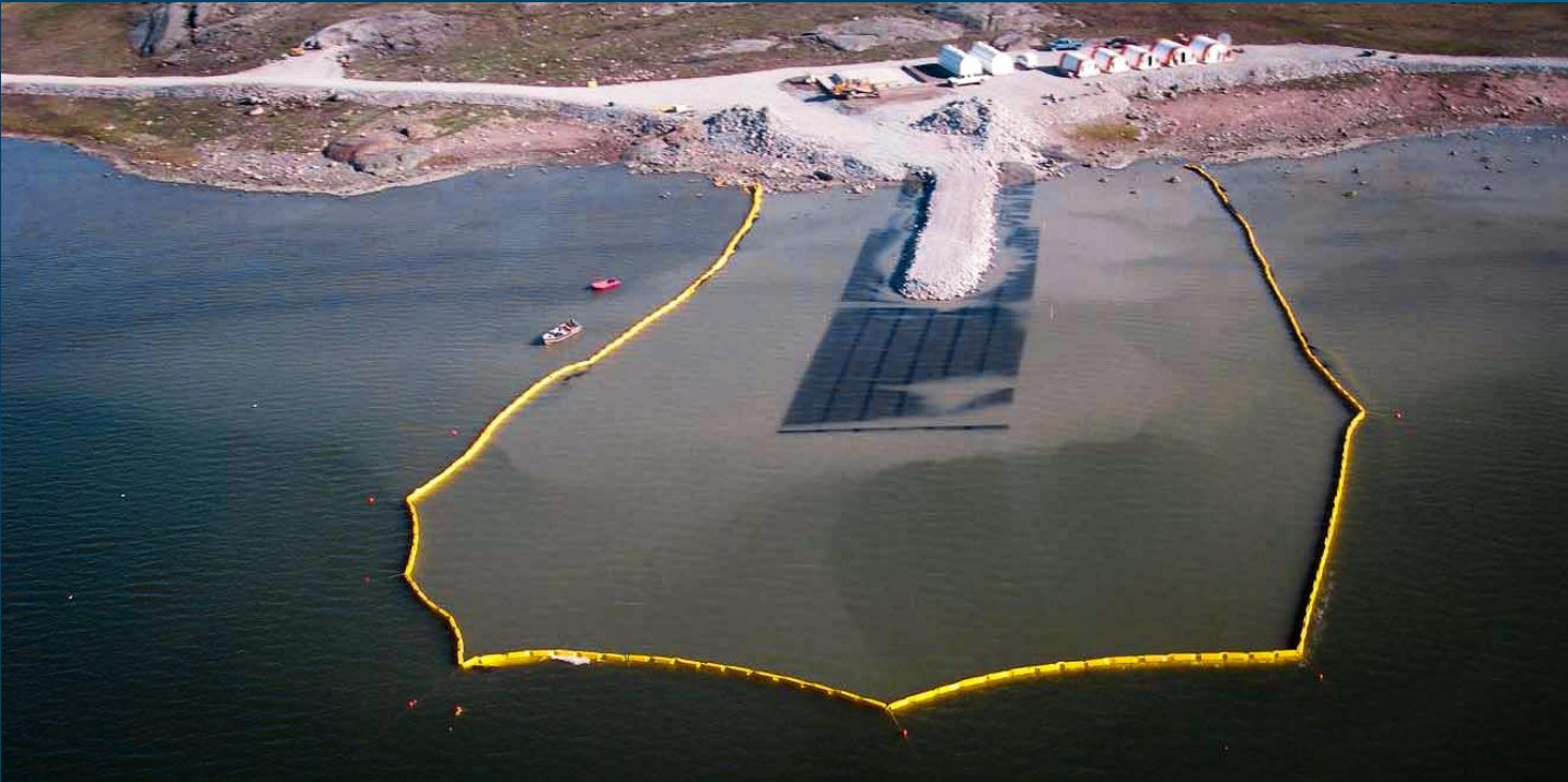
Contoh pemasangan silt curtain
