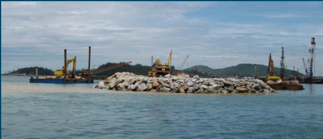
Pembinaan pemecah ombak dari laut dan darat
