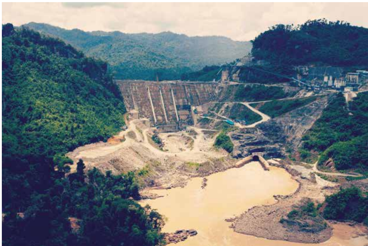
FOTO Empangan graviti Murum semasa dalam peringkat pembinaan. Takungan empangan telah mula diisi pada Julai 2013 dan penjana kuasa pertama pula diuji pada Disember 2014
