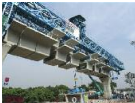
Ujian bebanan dijalankan ke atas gantri pelancar pertama di bawah Pakej V6 berhampiran Bandar Tun Hussein Onn pada 9 April 2013.
