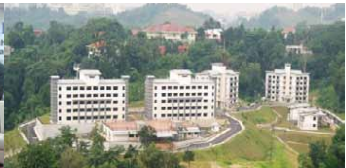
Bangunan baru Kompleks Akademi Pencegahan Rasuah Fasa II
