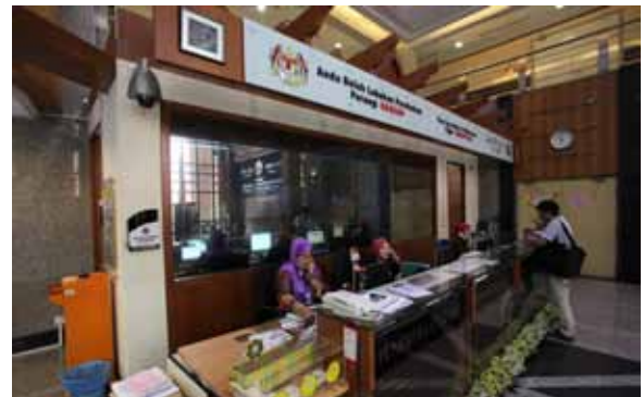
Kamera CCTV yang beroperasi di bangunan SPRM
